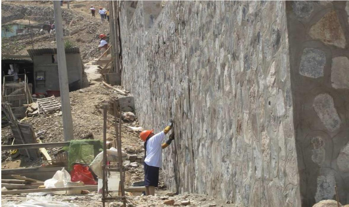
Trabajo de acabados (emboquillado) de los muros construidos. AA.HH. JORGE CHAVEZ
