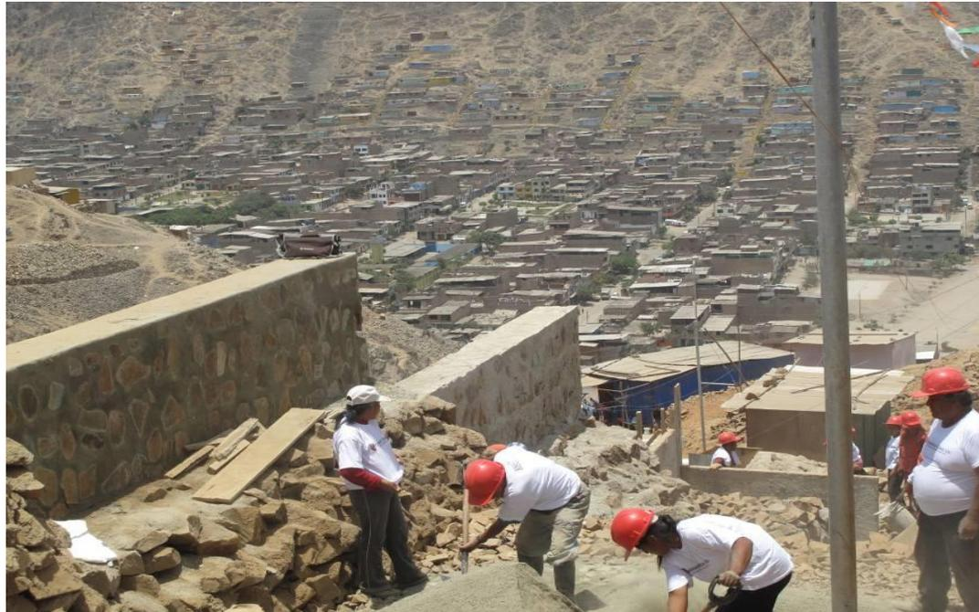
Trabajos de preparación de la mezcla de mortero para construcción de los muros.
