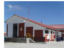
Planta Procesadora de Lácteos Planta de Fibra de Alpaca y Lana de Ovino Irrigación del Cañón del Apurímac
