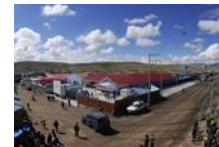
Construcción e implementación del Hospital Tipo II - I de Espinar
