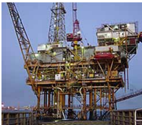
Construcción de plataforma en Lousiana, similar a la construcción que se realiza en Talara
