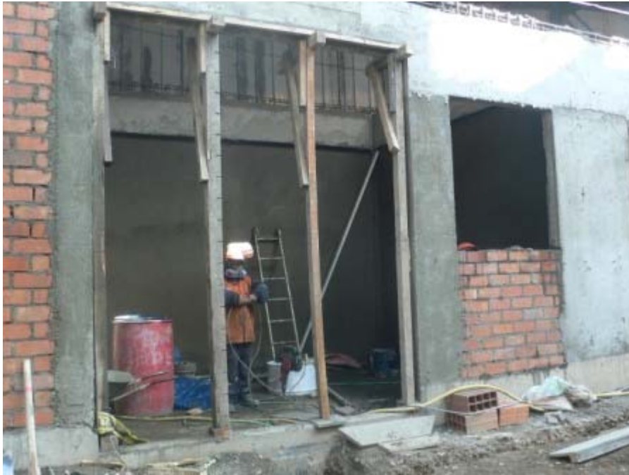
Construcción de taller mecánico
