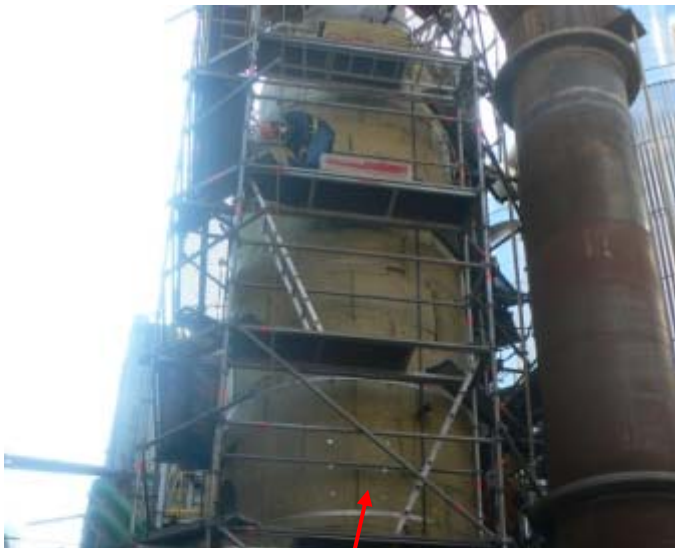
Instalación de aislamiento en Intercambiador Precalentamiento
