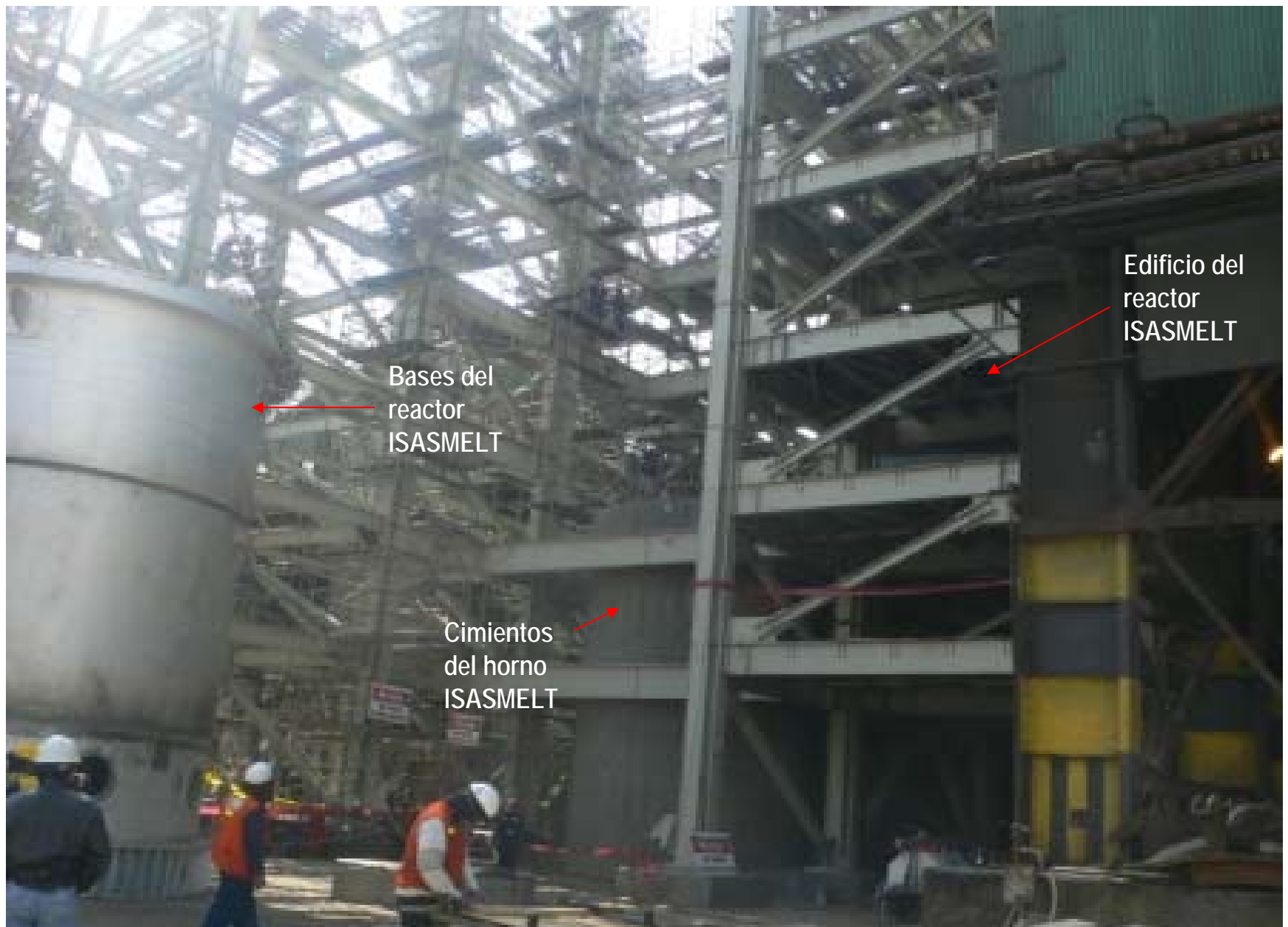
MODIFICACION DE CIRCUITO DE COBRE – 27 AGOSTO 2008
