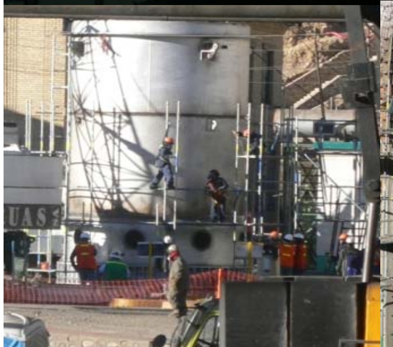
Montaje del reactor ISASMELT
