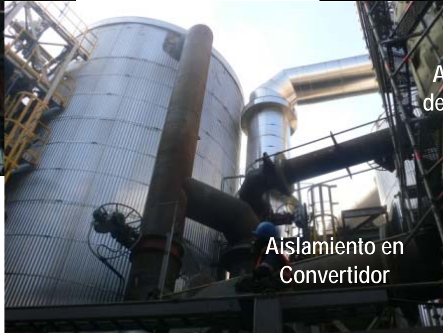
Instalación de aislamiento en Intercambiador Precalentamiento
