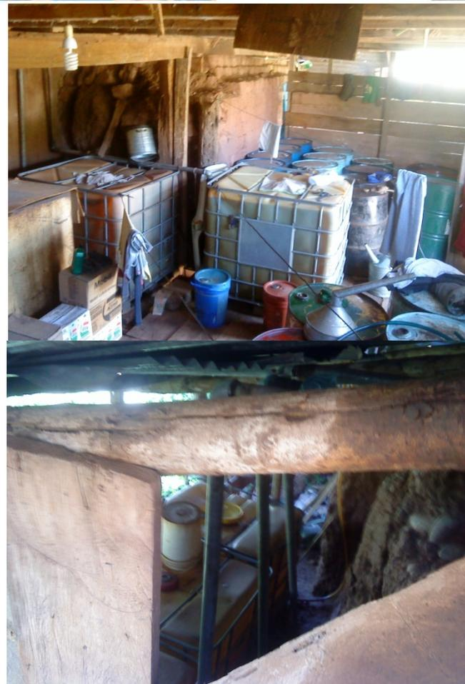
***Almacenamiento de combustible en tanques que han sido instalados sin ninguna medida de seguridad***
