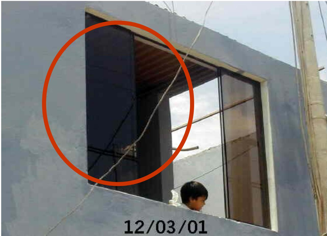
La transgresión a la Norma Técnica N° 011 de Conexiones para suministro de energía eléctrica, implica Riesgo Eléctrico.
