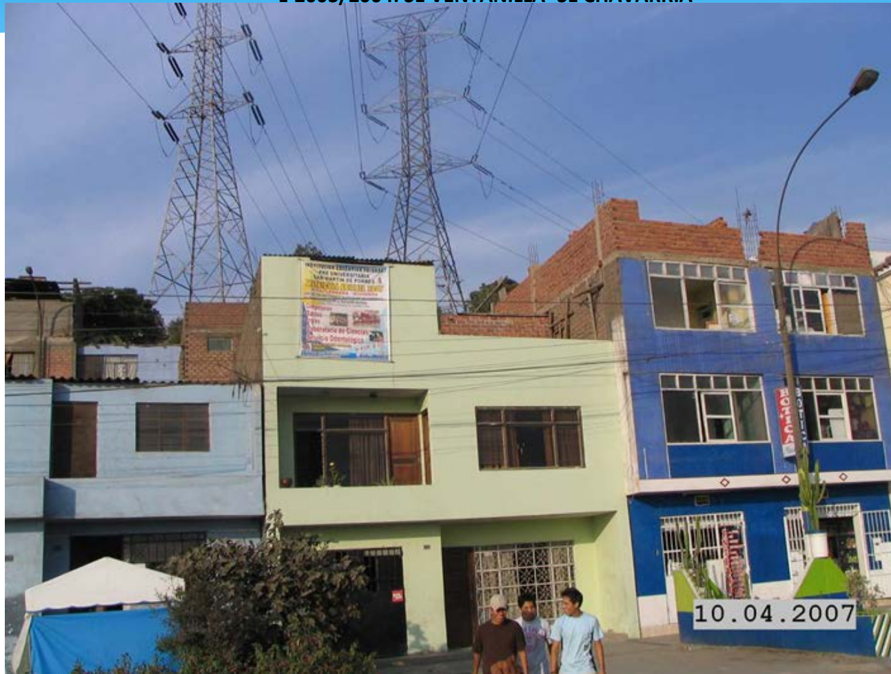
Foto 8.- Vano T16-T17: 20 construcciones. En la foto construcciones de material noble antiguas con ampliacion nueva debajo de la línea
