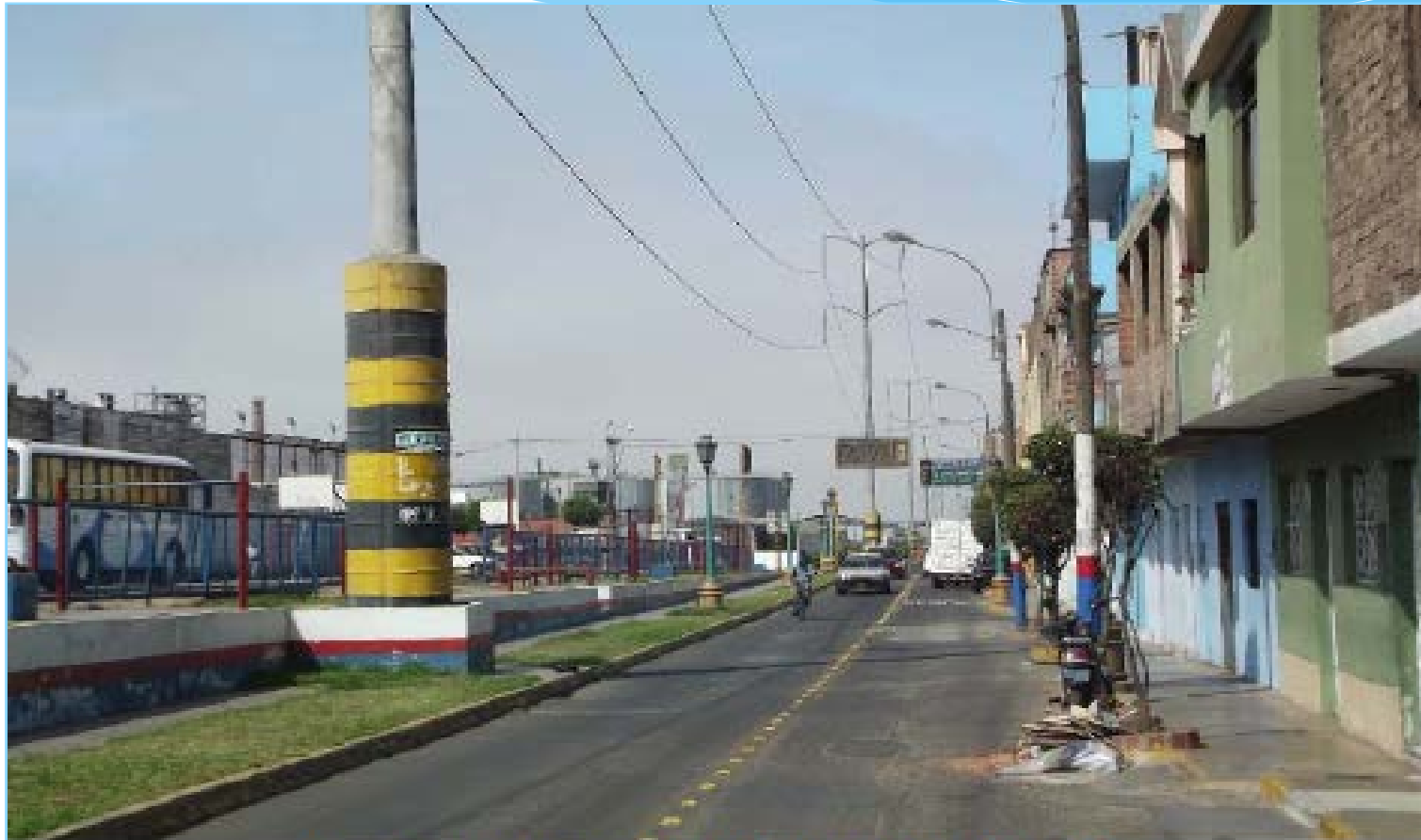
Foto N° 1: postes P29 y P30 de la línea 220 KV L-2005.
