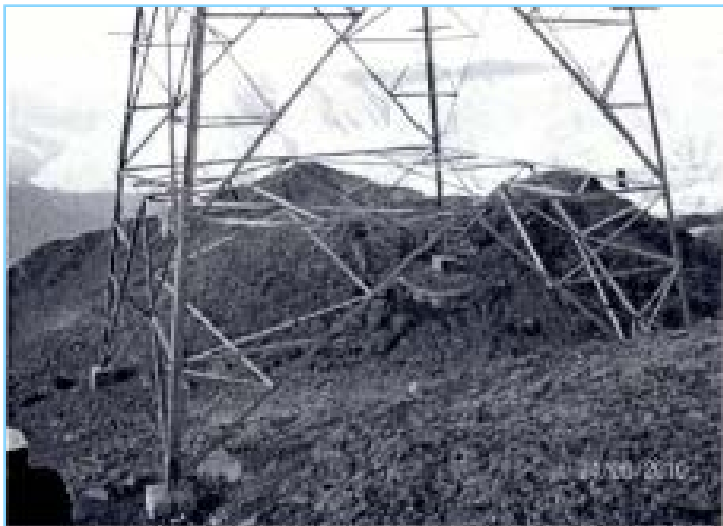
Figura 12. Terreno con suelo de roca monolítica.
