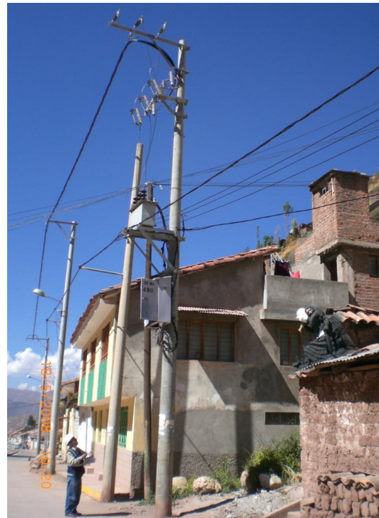
Inspección de Instalaciones de MT.
