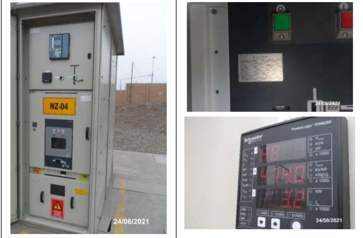
Foto 4. SET Huarangal. Celda de alimentador 10 kV (NZ-04). Celda metal clad, instalación exterior, simple barra
