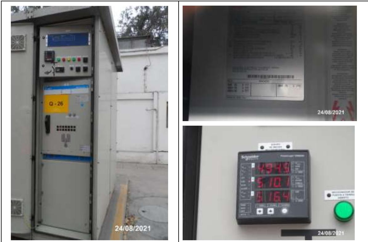
Foto 1 SET Pershing. Celda de alimentador 10 kV (Q-26). Celda metal clad, instalación exterior, simple barra.
