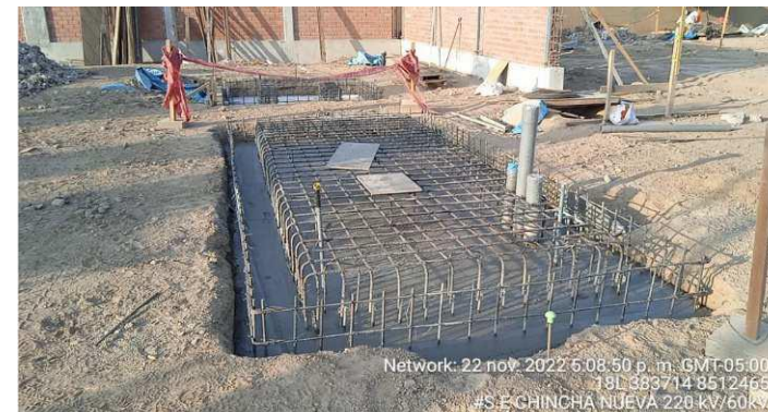
Cimentación de Grupo Electrogeno control
