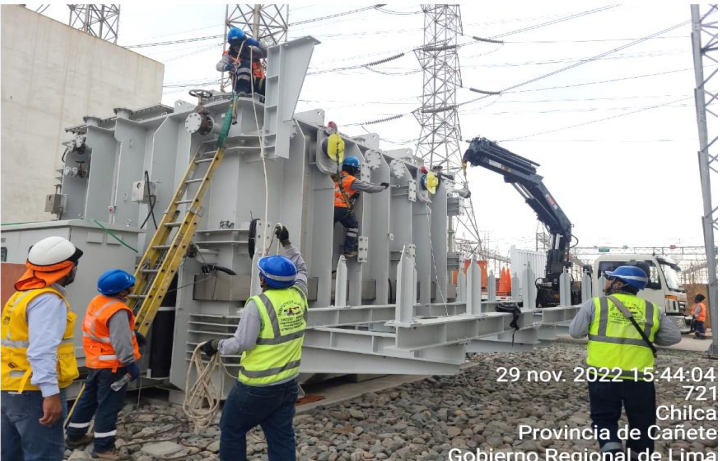
S.E. Chilca: Trabajos de montaje en autotransformadores
