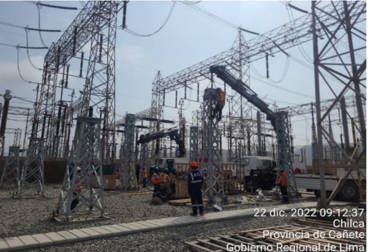
S.E. Chilca: Montaje Electromecánico
