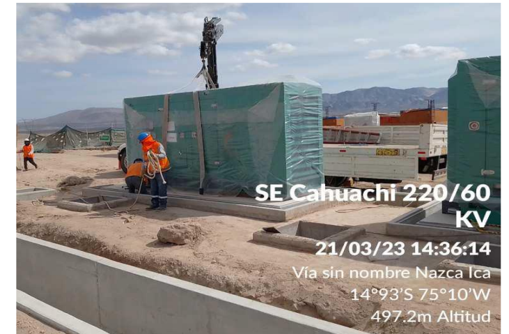
Descarga de grupos electrógenos en su base
