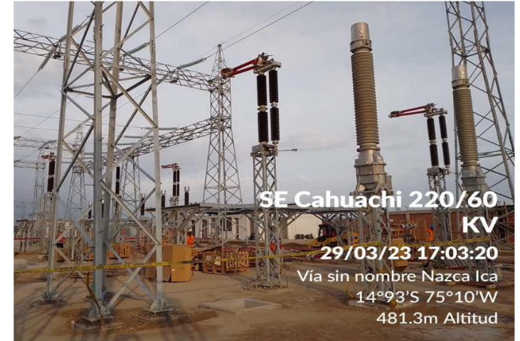
Izaje de los brazos de los seccionadores del patio de 220 kV
