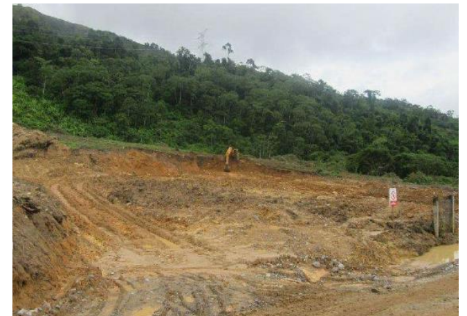
Trabajos en los caminos de acceso a la futura S.E. Leoncio Prado
