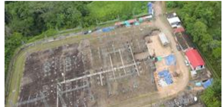
Avance de obras en la S.E. Aguaytía
