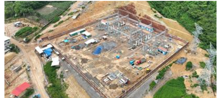
Avance de obras en la S.E. Leoncio Prado
