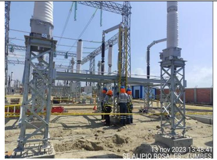
Calibración de seccionadores
