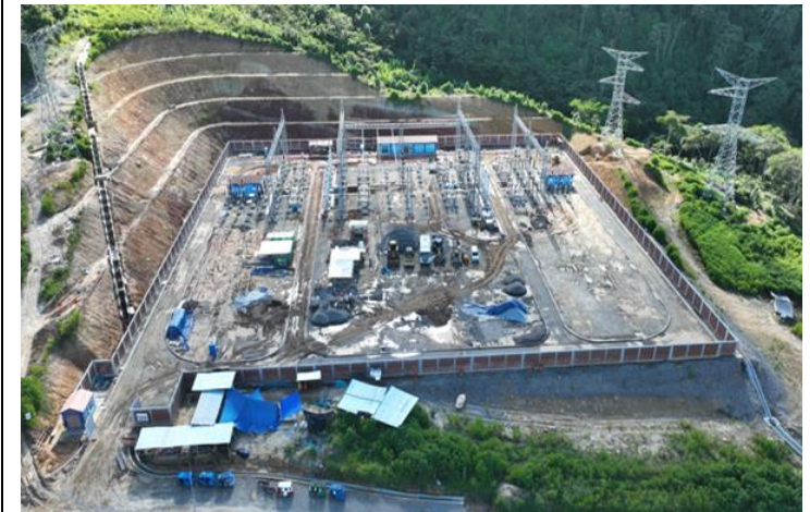
Avance de obras en la S.E. Leoncio Prado
