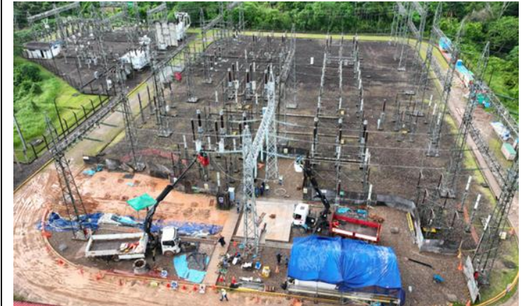
Avance de obras en la S.E. Aguaytía
