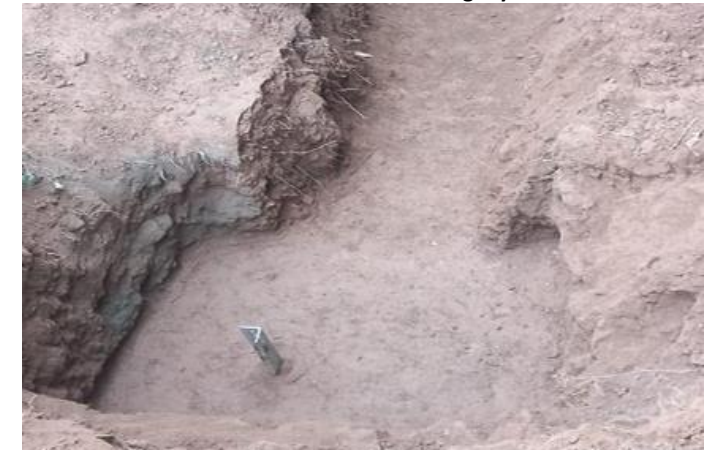
Relleno y compactado T104
