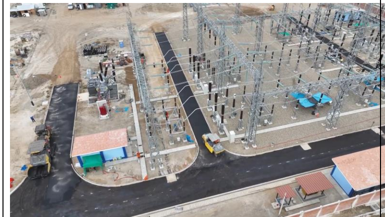
S.E. Alipio Rosales: Asfaltado de las vías internas
