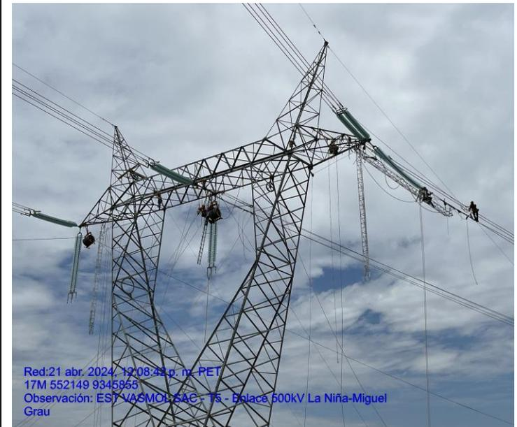
**Montaje de conductor T05 de la LT 01**
