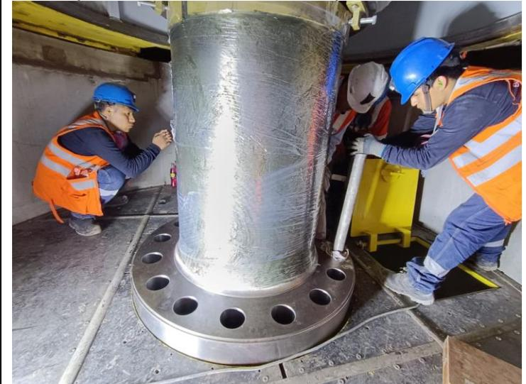
Eje del rotor GTA 1 en proceso de montaje
