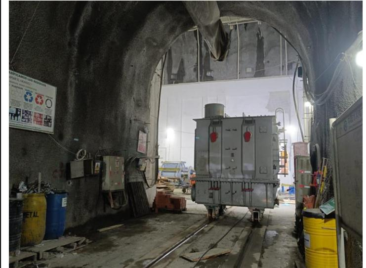
Caja de transformador de 240 MVA en proceso de traslado
