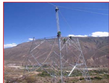
Montaje de Estructuras (T 138)
