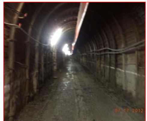
Ventana hacia túnel de Conducción
