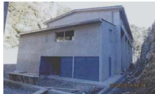
Construcción de la Casa de Máquinas
