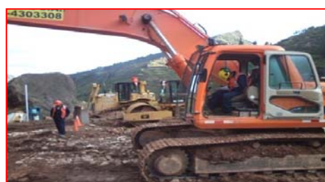
Desbroce del terreno para casa de máquinas
