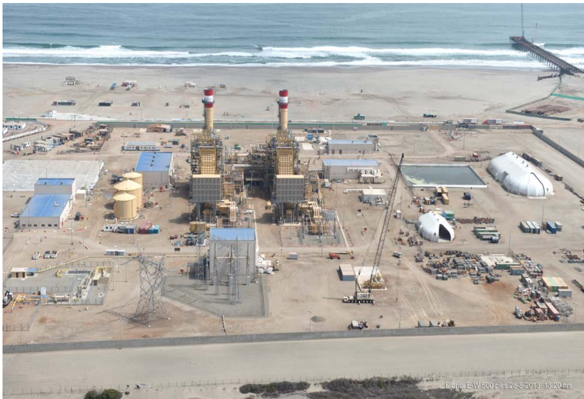
Ilustración 4: Foto Panorámica C.T. Ciclo Combinado Chilca (534,3 MW)
