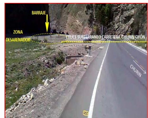
Cruce del ducto subterráneo de la C.H. Viroc
