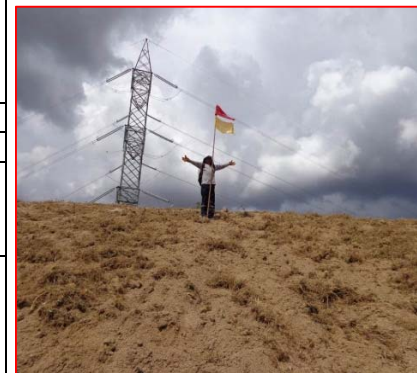
Trabajos de Exploración y Bandereo- Tramo I
