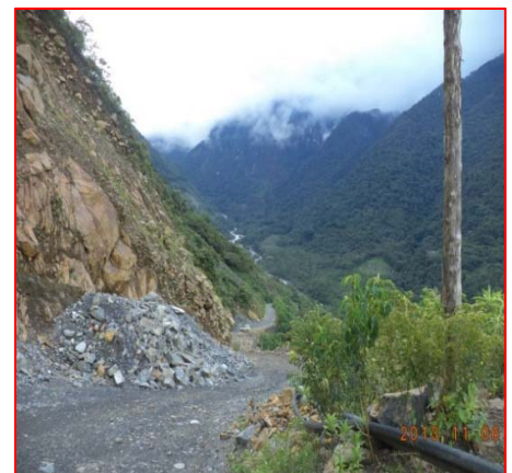
Caminos de acceso a las obras de construcción C.H. Ángel III
