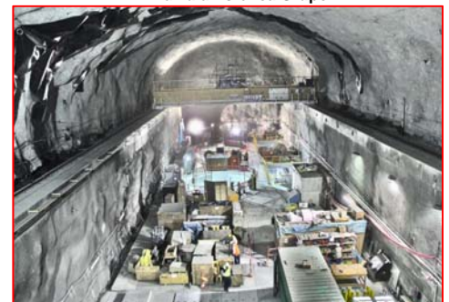
Vista de la Casa de Máquinas
