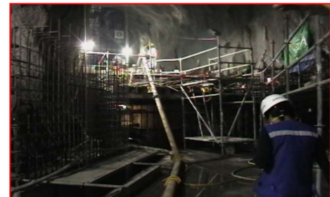
Vaciado de Concreto S.E. en Caverna
