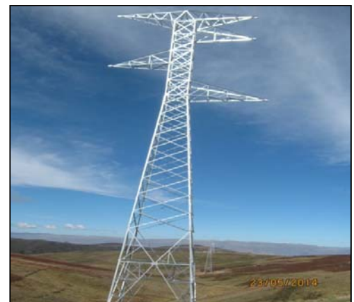
Vistas de Torres en la L.T.
