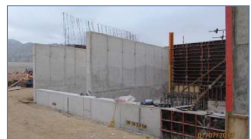
Cimentaciones de los transformadores
