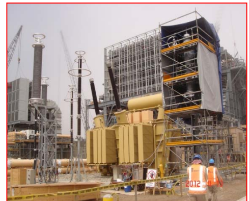
Montaje de Transformador de Potencia de T.G.
