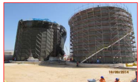
Trabajos de acabados en tanques de combustible
