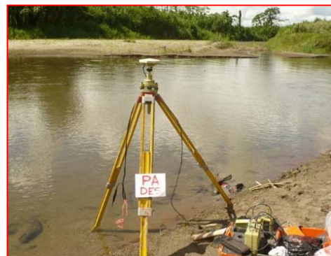
Zona de descarga –Trabajos Topográficos
