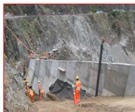
Ingreso del acceso a Casa de máquinas CH Carpapata III
