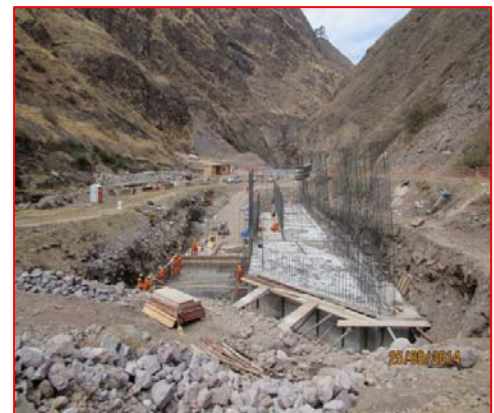
Trabajos de construcción de la Bocatoma
