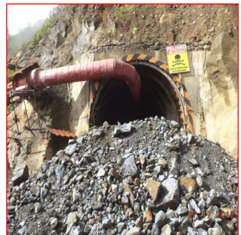
Ventana de acceso para construcción del túnel de conducción
