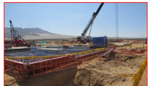
Obras civiles en el área del Black Star
