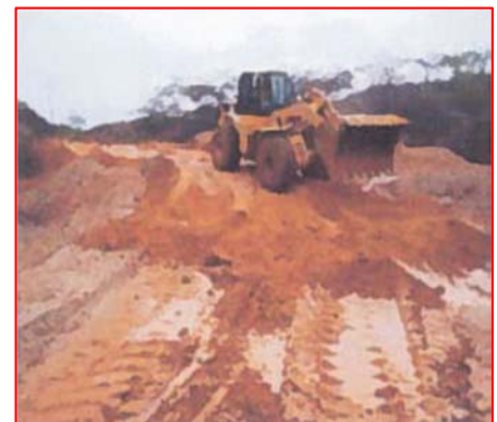
Corte del Terreno
