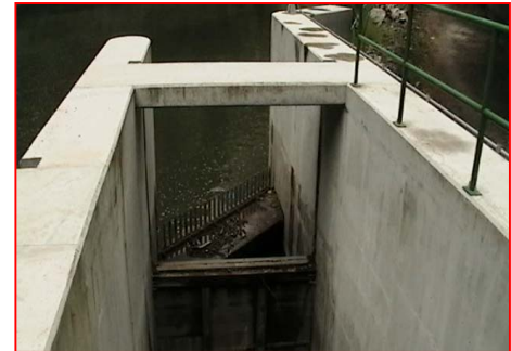
Ingreso de canal nuevo
