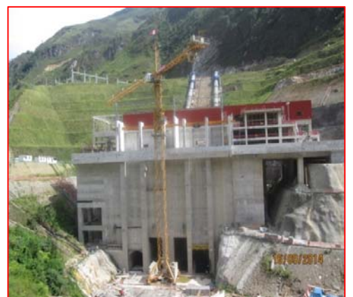
Vista de la Casa de máquinas
