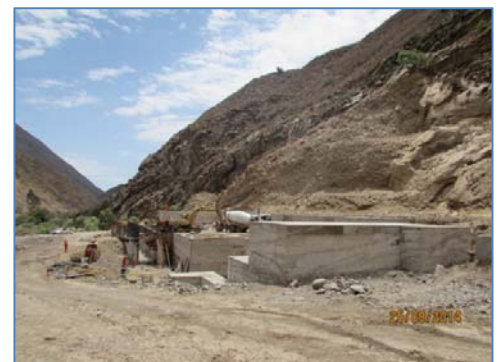
Obras civiles Casa de máquinas
