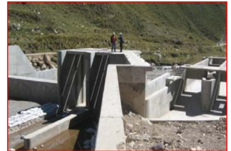
Vista panorámica Bocatoma
