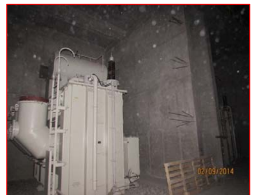
Transformador de potencia en caverna (S.E. Quitaracsa)
