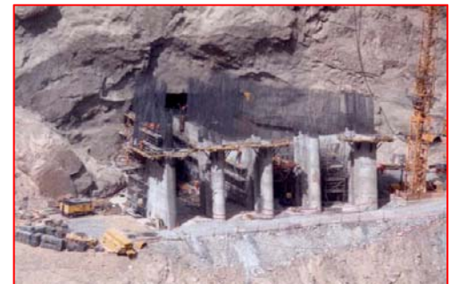
Obras de Toma (Colocación de acero y vaciados)
