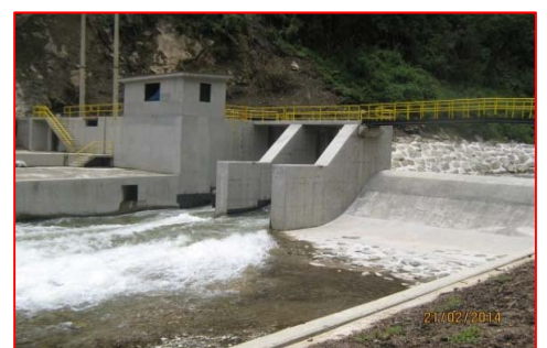
Barraje fijo y móvil de la Bocatoma
