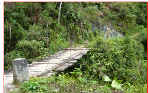
Puente Unión, encima del río El Carmen, la Bocatoma se encuentra a la izquierda
