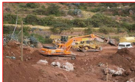
Nivelación de terreno para canal de conducción
