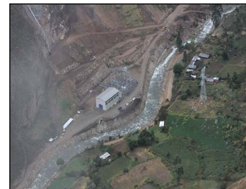
L.T. 220 kV SE Runatullo III – SE Concepción
