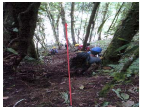
Obras preliminares: Estudios de suelos
