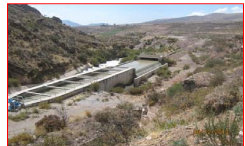
Salida del Túnel (Estructura Existente)
