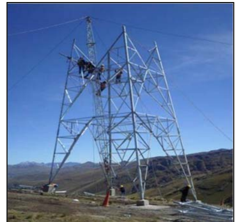
Montaje de Torre T266
