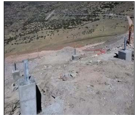
Vaciado de concreto en la Torre T108
