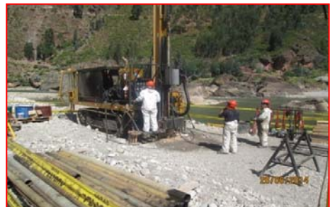
Preparación de Terreno para presa
