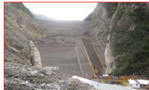
Presa vista aguas arriba
