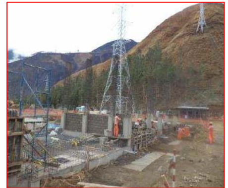
Construcción de Muros Cortafuegos S.E. Suriray
