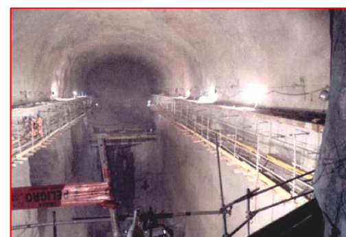
Caverna de Casa de Máquinas
