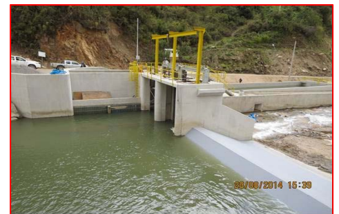
Bocatoma y Desarenador
