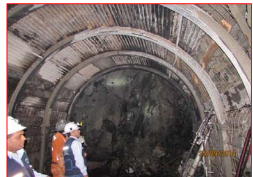
Excavación del túnel de salida
