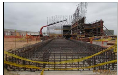
Área del transformador principal, trabajos de cimentación y muros cortafuegos
