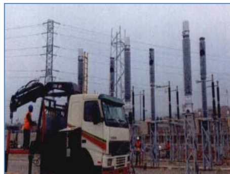
Montaje de Transformador de Corriente S.E. Chilca
