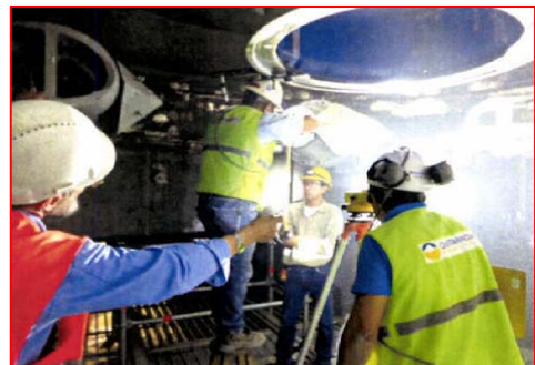
Montaje de Equipos-Trabajo en Inyectores
