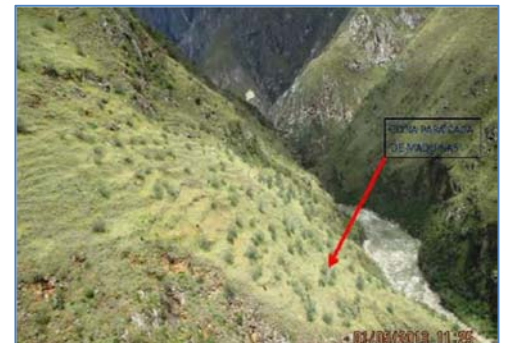
Zona de Casa de Máquinas
