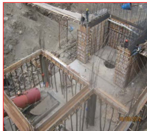
Trabajos en la Casa de Máquinas
