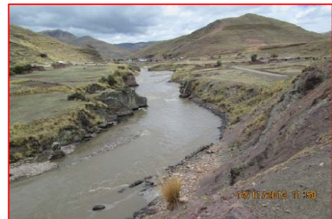
Bocatoma Santa Bárbara
