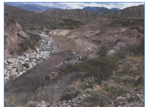
Obras preliminares zona de toma
