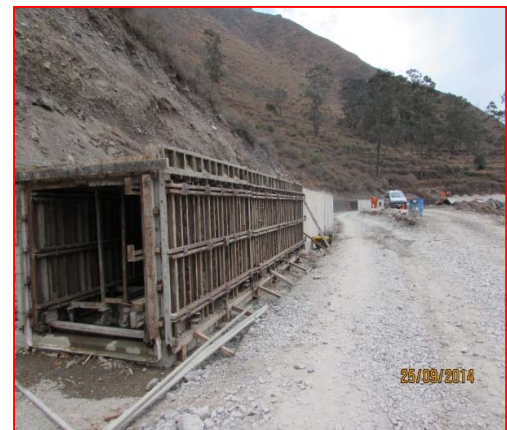
Obra civil del canal de conducción, tramo Rapacán-Cutin
