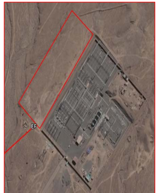
Futura S.E. Ilo 4
