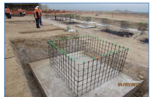
Obras civiles en subestación elevadora
