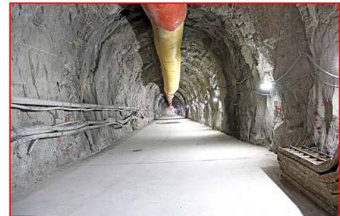
Túnel de Descarga
