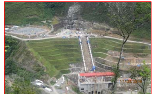
Vista de la casa de máquinas
