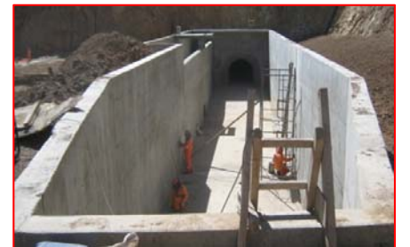
Acabados en la cámara de carga
