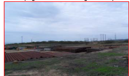
Zona de Ubicación de la C.T. Nueva Esperanza
