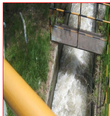
Aguas Turbinadas Carpapata II que se captara en Carpapata III
