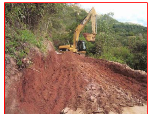
Obras Preliminares - Carretera
