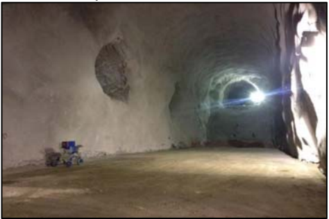
Caverna de Transformadores
