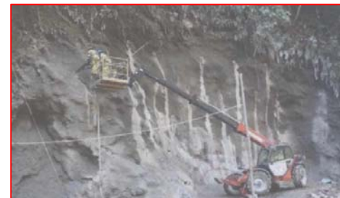
Sostenimiento de Talud con pernos de anclaje
