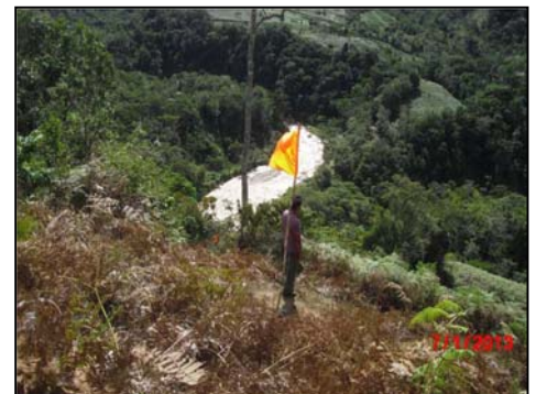
Trabajos de Replanteo de la L.T. (Vértice V1)
