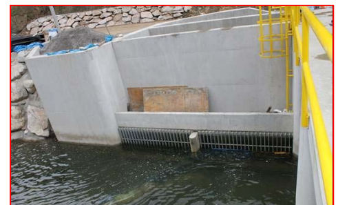
Ventana de captación
