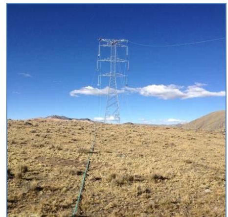
Tendido de Guaya en la Torre T243
