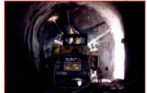
Túnel de conducción Aguas Abajo-Frente Presa
