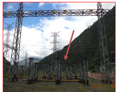
Espacio reservado para Celda de Llegada CC.HH. Ángel I-II-III
