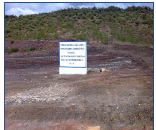
Camino de Acceso a Plataforma de la S.E. Aguas Calientes
