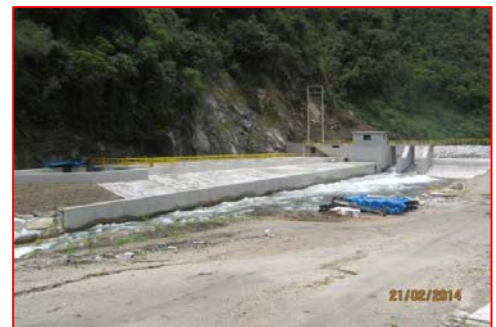
Vista de la Bocatoma
