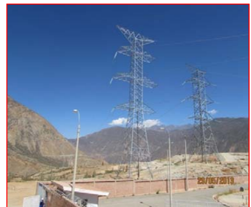
Estructura N° 14 de la L.T. 220kV, S.E. Quitaracsa I-S.E. Kiman Ayllu
