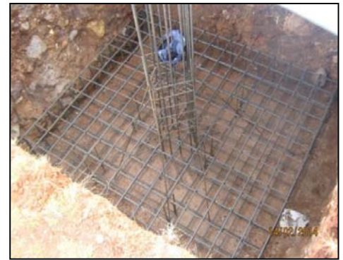
Colocación de acero en Zapata de Torre tipo A
