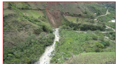
Zona de Casa de Máquinas y accesos en la zona del proyecto
