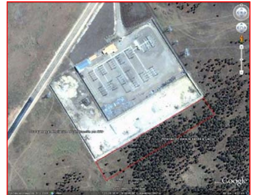
Ampliación de S.E. Cajamarca Norte 220 kV
