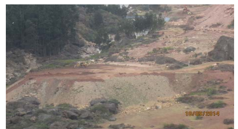
Desbroce y nivelación de terreno
