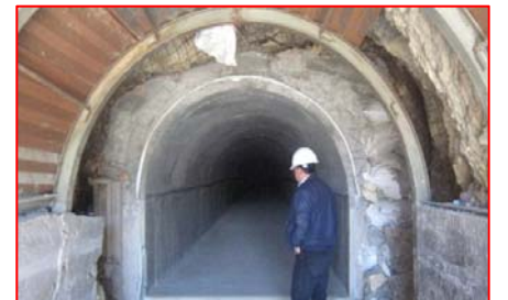
Vista del Túnel
