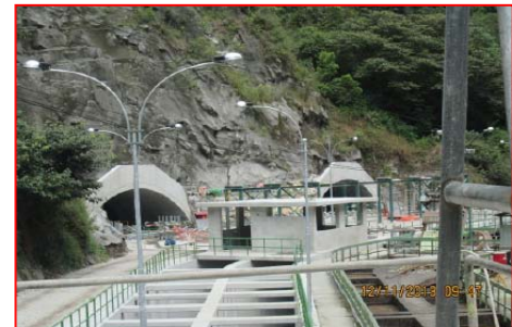
Construcción de los desarenadores
