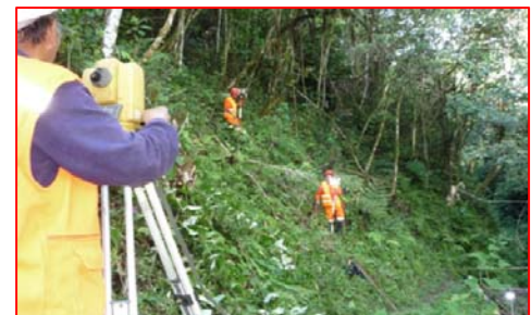
Replanteo topográfico Casa de Máquinas-Bocatoma
