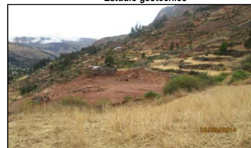
Desbroce y nivelación de terreno para subestación Tipos de Estructuras
