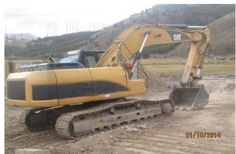
Maquinaria en Obra
