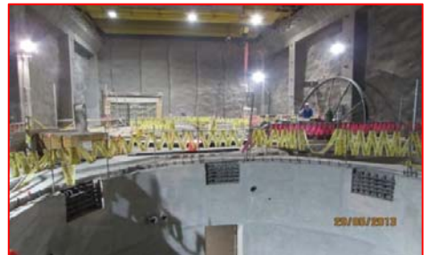
Vista de Casa de Máquinas
