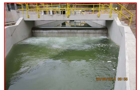
Vista del canal de conducción
