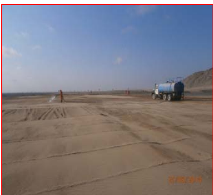
Adecuación de terreno de la subestación Reque
