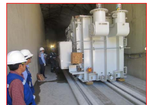
Montaje del Transformador C.H. Machupicchu
