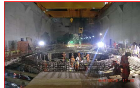
Trabajos en Casa de Máquinas
