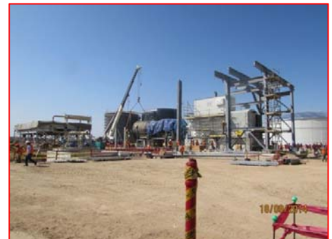
Trabajos de instalación del Grupo turbina-generator
