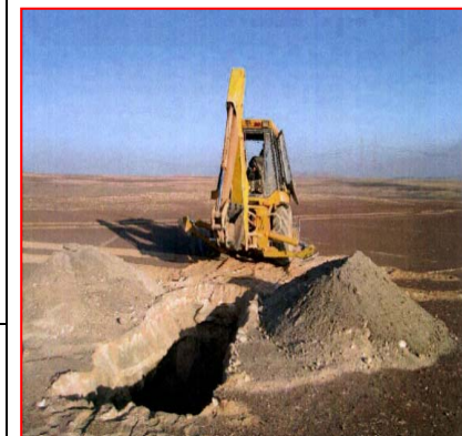
Estudios de Geotecnia
