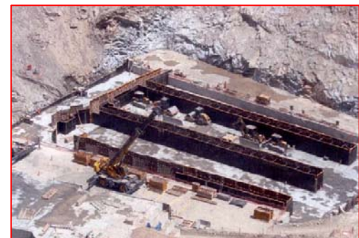
Presa bloque 1,2 y 3 -Trabajos de encofrado para galerías
