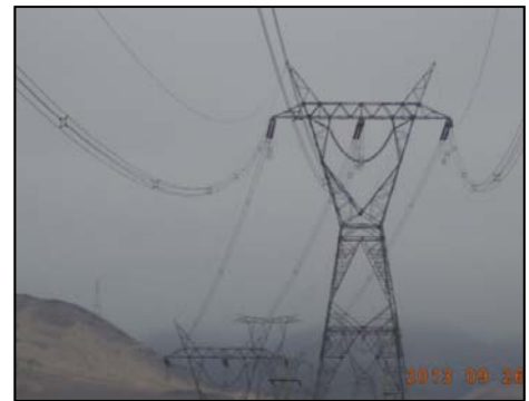
L.T. 500 kV S.E. Fénix – S.E. Chilca
