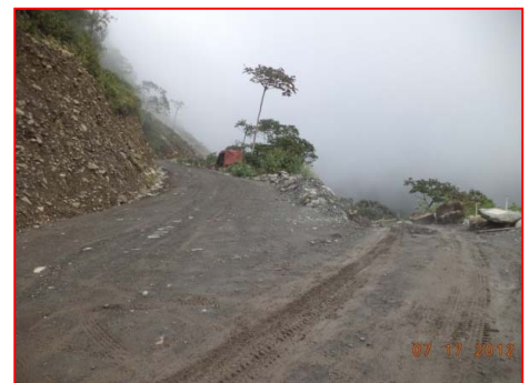
Acceso al túnel de entrada C.H. Ángel II (derecha)
