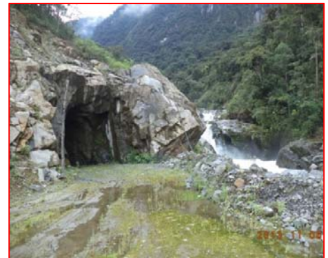
Túnel de acceso a casa de máquinas C.H. Ángel II
