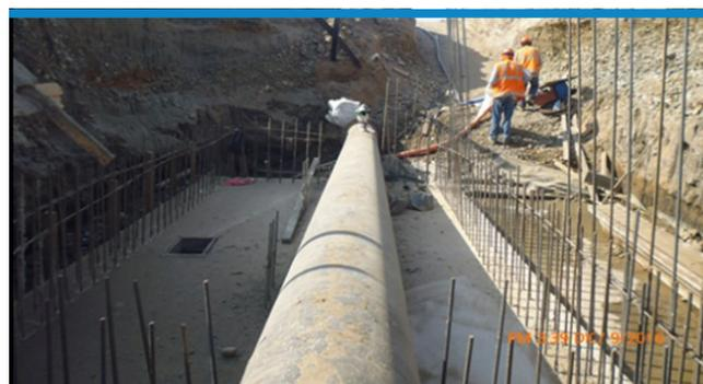
Vista de la armadura para los muros de la cámara de válvula, proyecto Reubicación Av. Néstor Gambetta tramo III-B malla 002, provincia del Callao.
