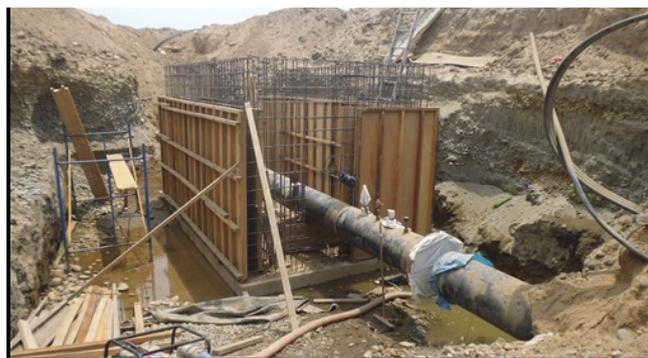
Bombeo de la napa freática durante la construcción de la cámara de válvula, proyecto Reubicación Av. Néstor Gambetta tramo III-B malla 002, provincia del Callao.
