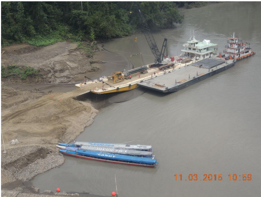
Foto 01: Vista aérea del embarcadero de Ticumpinia: lado derecho la barcaza de transporte de tubos, lado izquierdo la barcaza de carga a las carretas o dollys para su traslado a punto de acopio en tierra.
