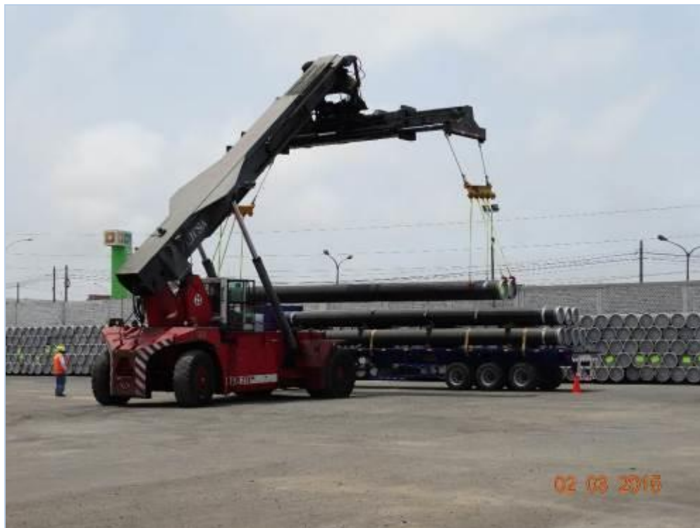
Foto-03: Carguío de tubería sobre camión trayler, nótese que cada tubo está sujetado de manera independiente.
