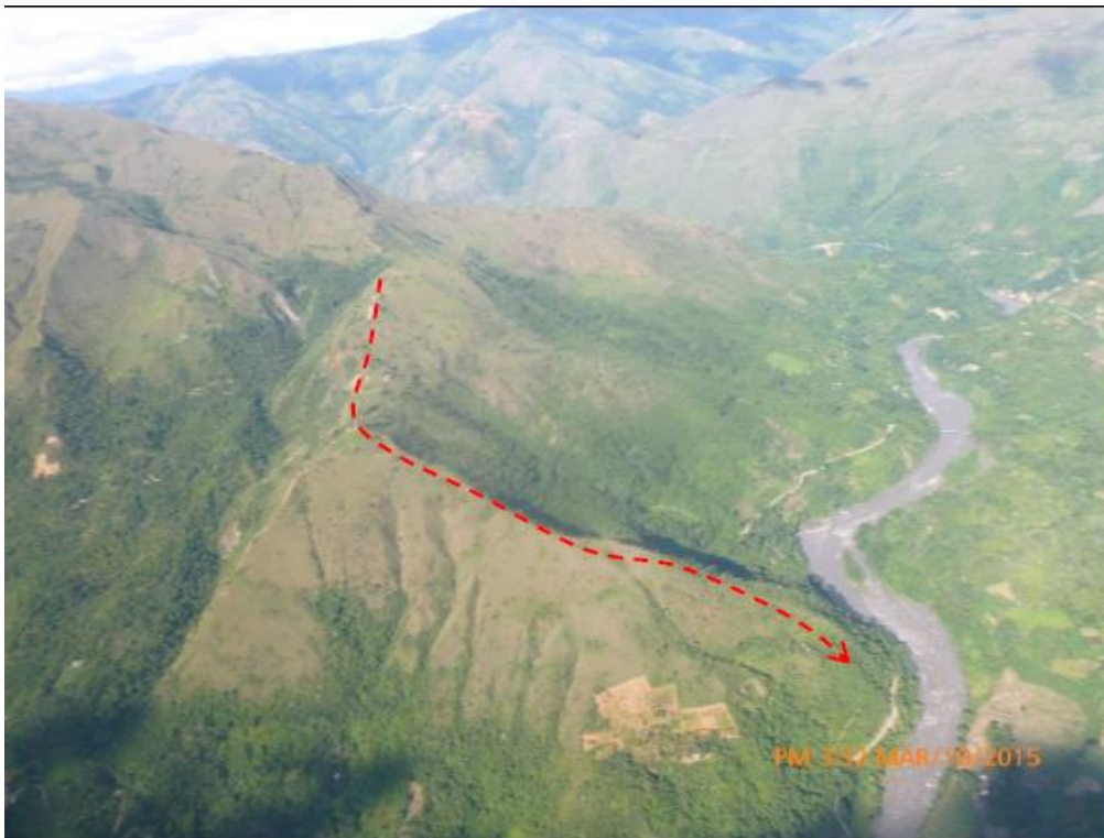
Foto-03: UTM: 18L: 763174E, 8592036N.- Panorámica del trazo por la línea de cumbres frente al poblado de Echarati
