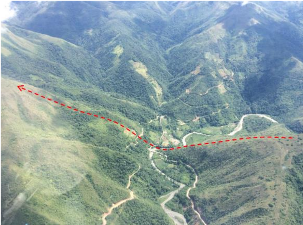
Foto-07: KP 130+000 al KP 131+000.- Taza de la troncal del GSP en quebrada profunda con pendientes de fuerte ángulo.
