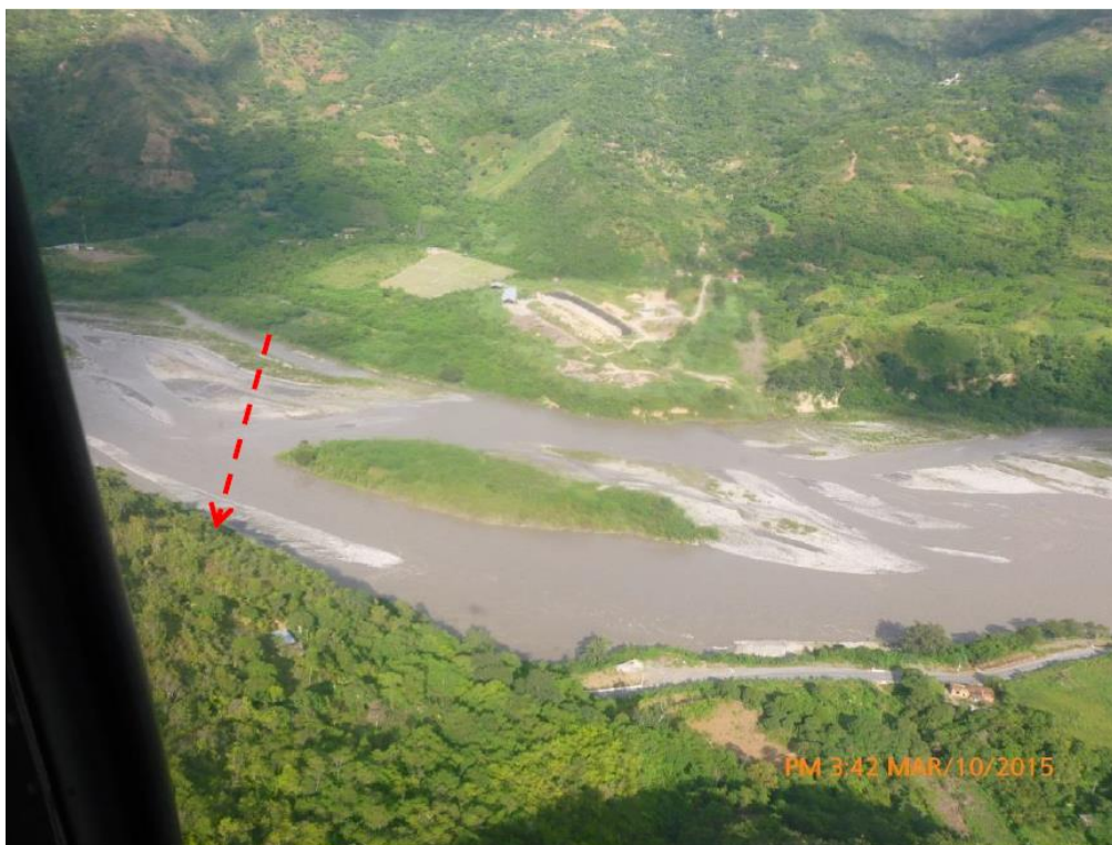
Foto-02: UTM: 18L: 750415E, 8580842N.- Cruce de la traza del ramal Quillabamba con el río Vilcanota, cerca al City Gate.
