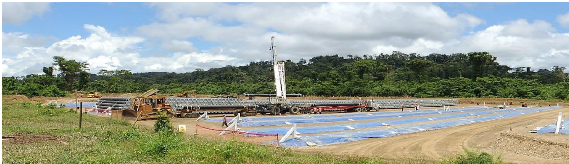
Foto 03: Campamento de Ticumpinia Vista del acopio de tubos de 24"Ø.
