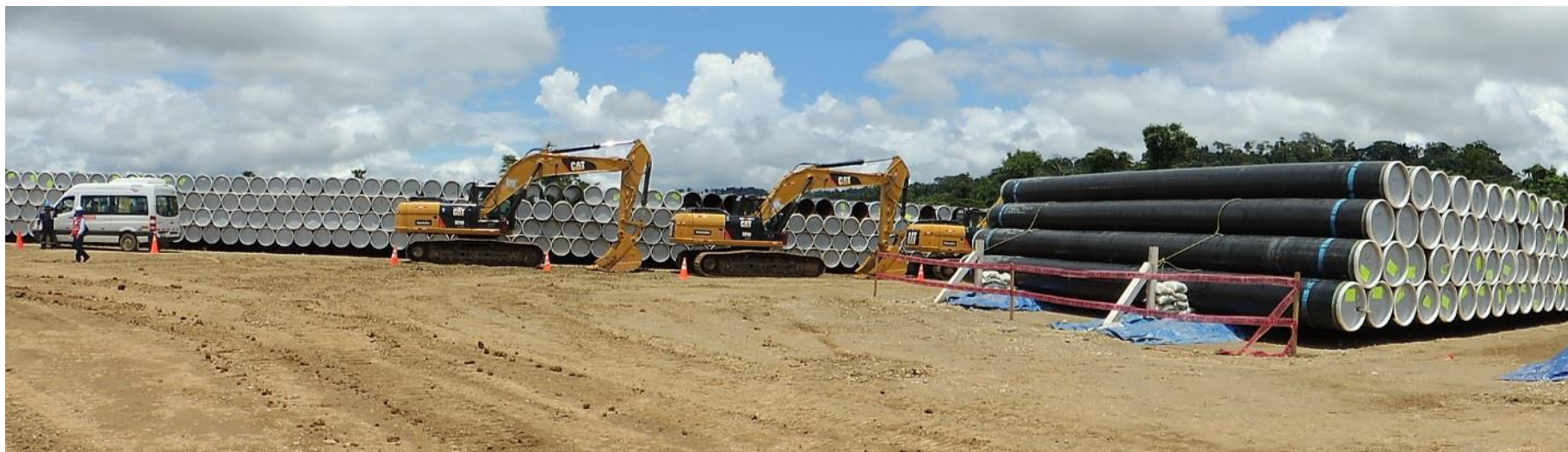
Foto 02: Campamento de Ticumpinia Vista del acopio de tubos de 32"Ø
