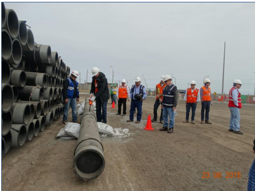
Foto 10. Pasando la herramienta holiday para verificar el estado del revestimiento de un tubo de 14", conforme.
