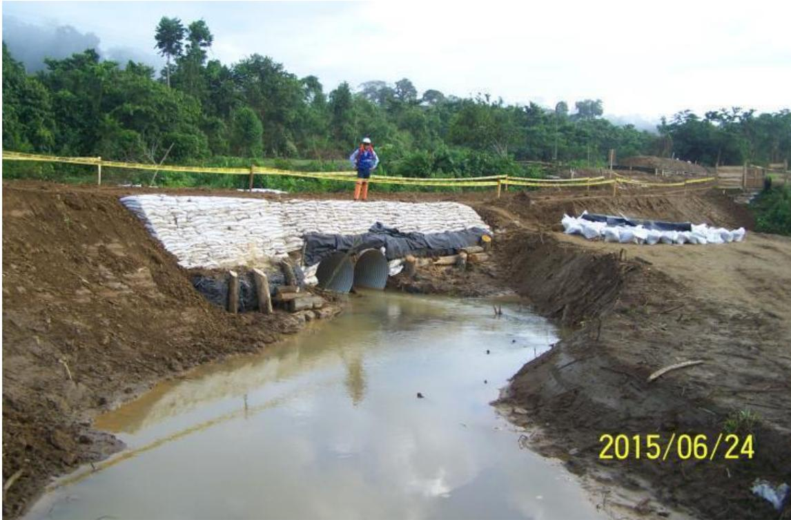
Foto 07. KP\_0006+000 al KP\_0008+100. Vista del DdV en construcción con los sistemas de drenaje preventivos.
