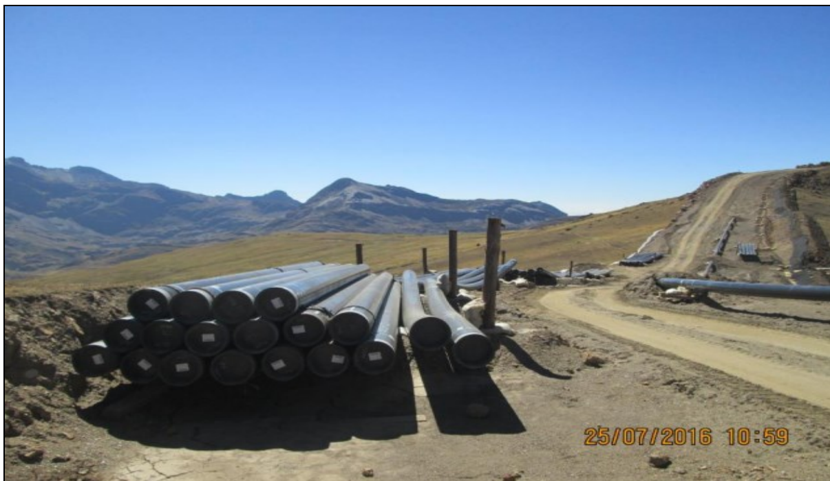
Tramo A1 - Gasoducto Secundario Cusco/Anta, KP 7+305 Verificación de la integridad de tubos en los acopios temporales.
