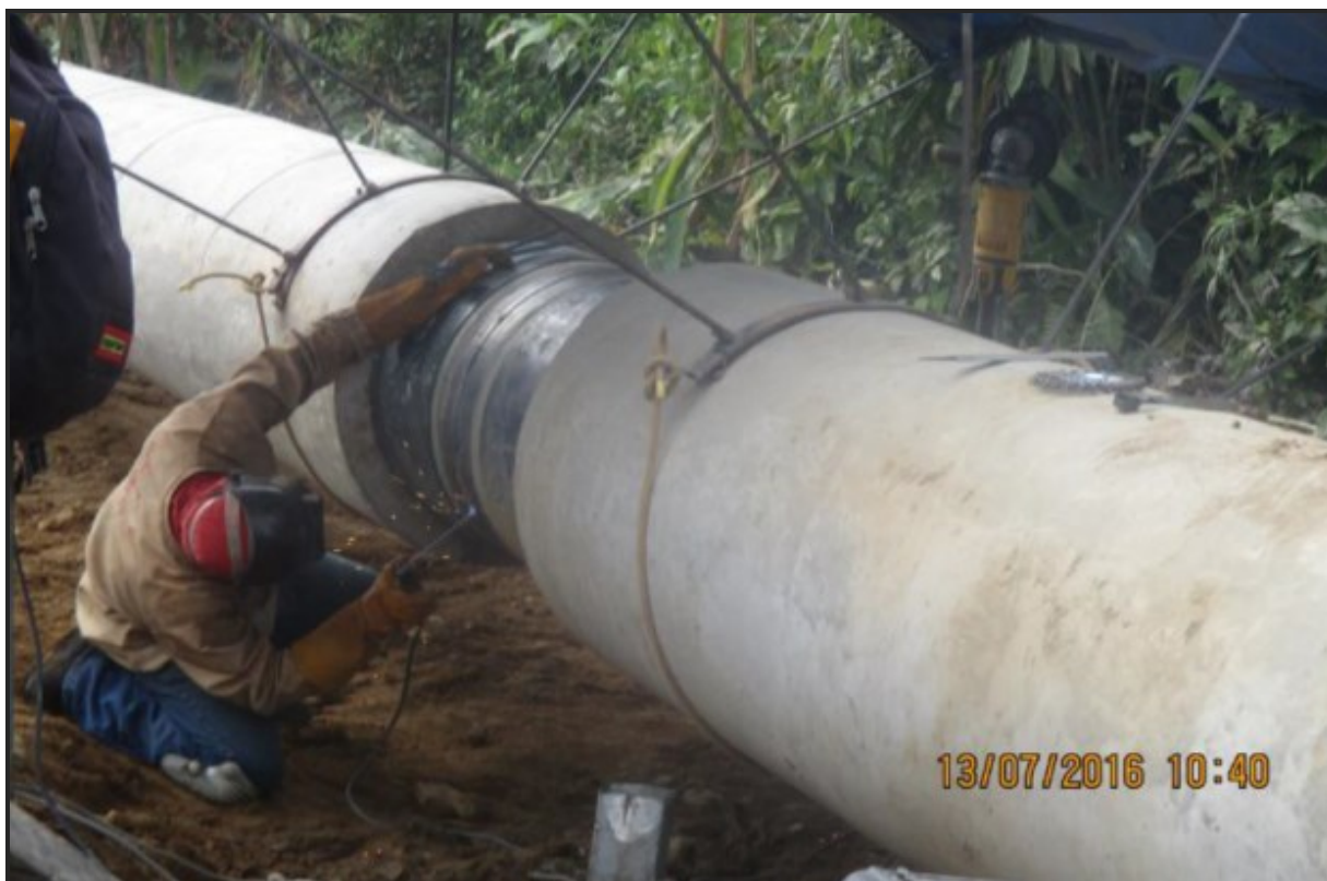
Tramo B - Segmento 1, KP 14+396. Soldadura de la junta J14/33, del cruce de río Capanashiari.
