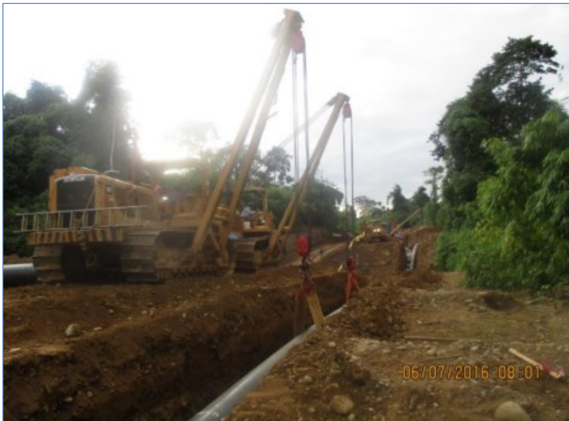
Tramo B – Segmento 1, KP 16+847. Bajado de la tubería.
