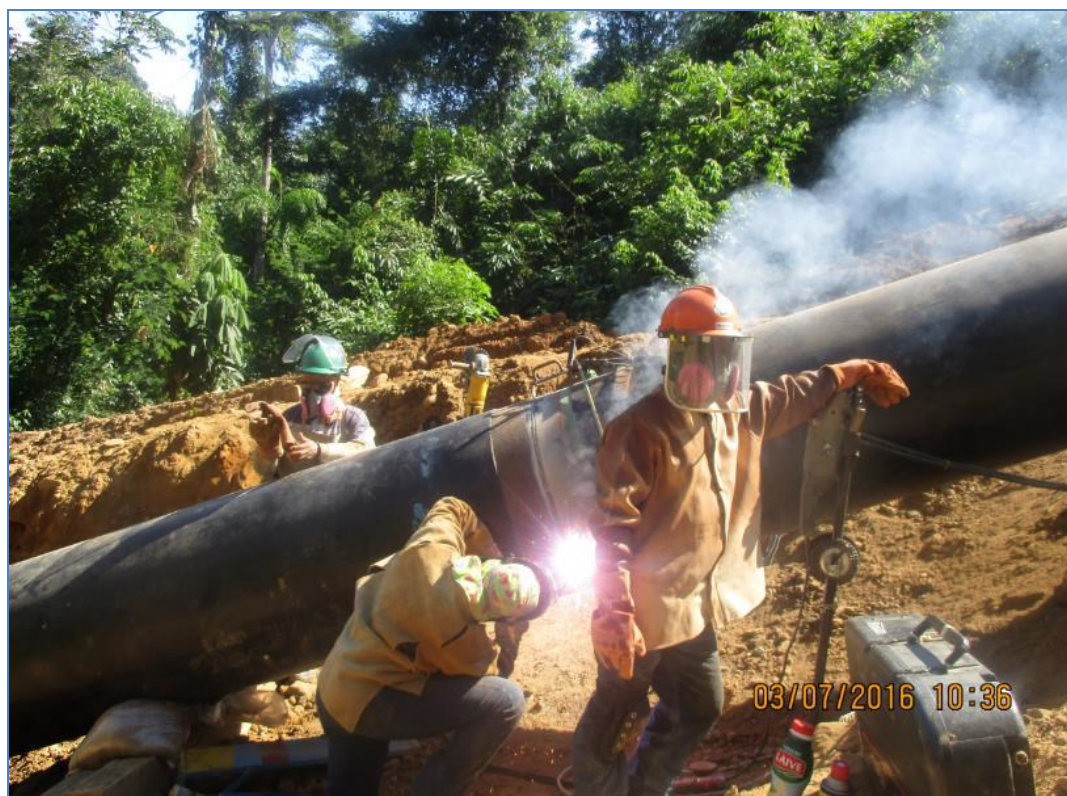
Tramo B - Segmento 1, KP-0011+864. Soldadura de tubería de 32" (unta 11/73).
