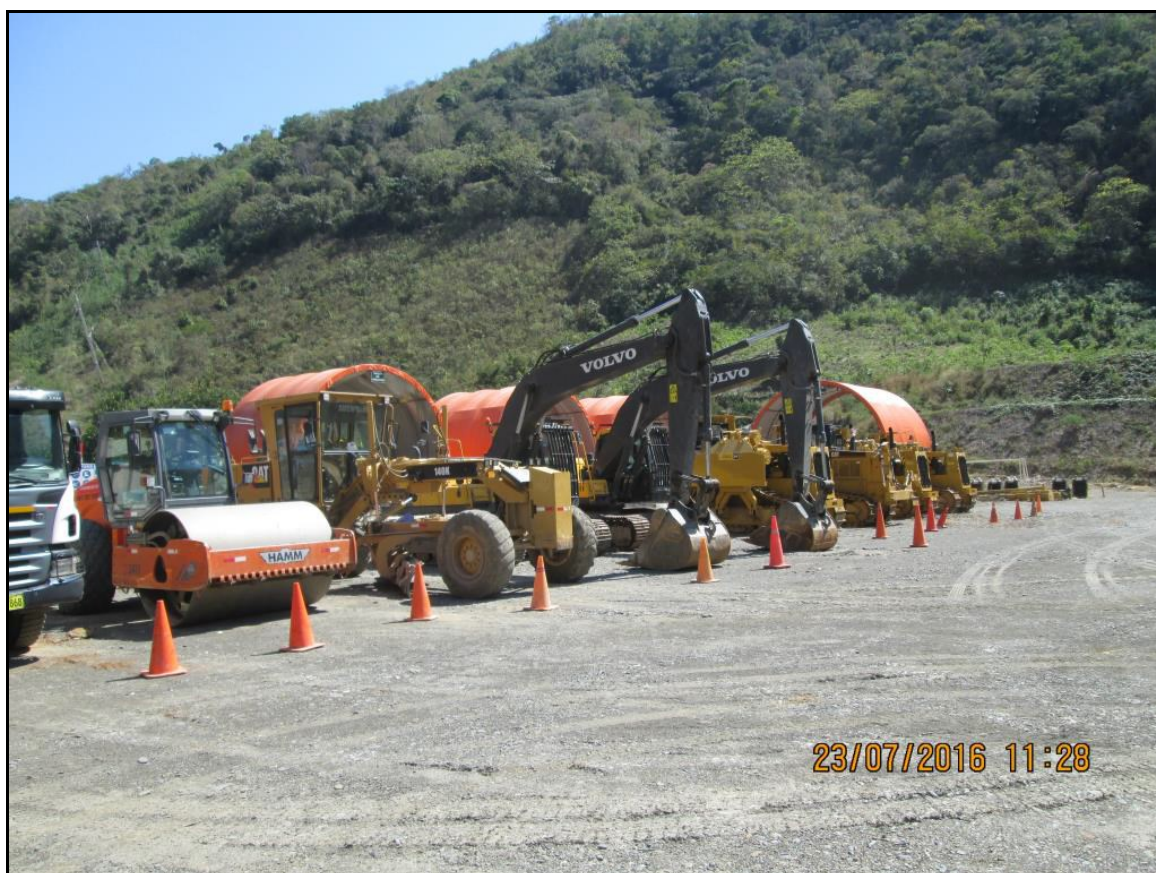
Tramo A1 – Gasoducto Secundario Quillabamba, KP 06+000. Maquinaria de construcción estacionada.
