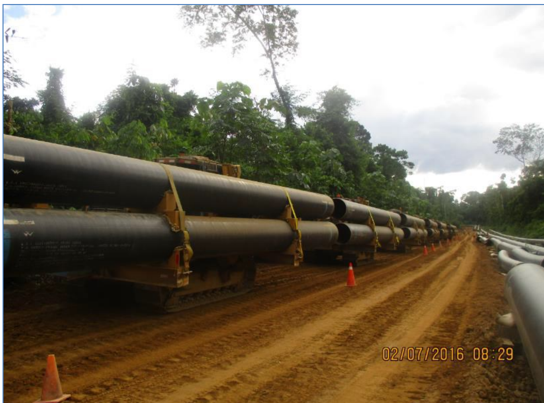
Tramo B - Segmento 1, KP-0010+000 Transporte de tubería de 32", a través de seis pipe carriers , al KP 22+100.
