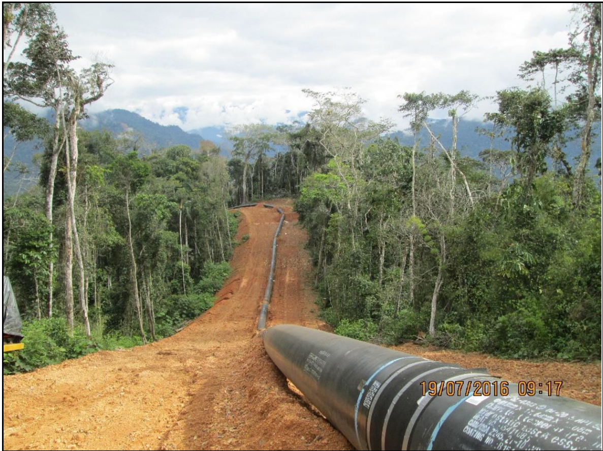
Tramo A1 – Segmento 3, KP-0088+976. Ducto de 32" Ø.
