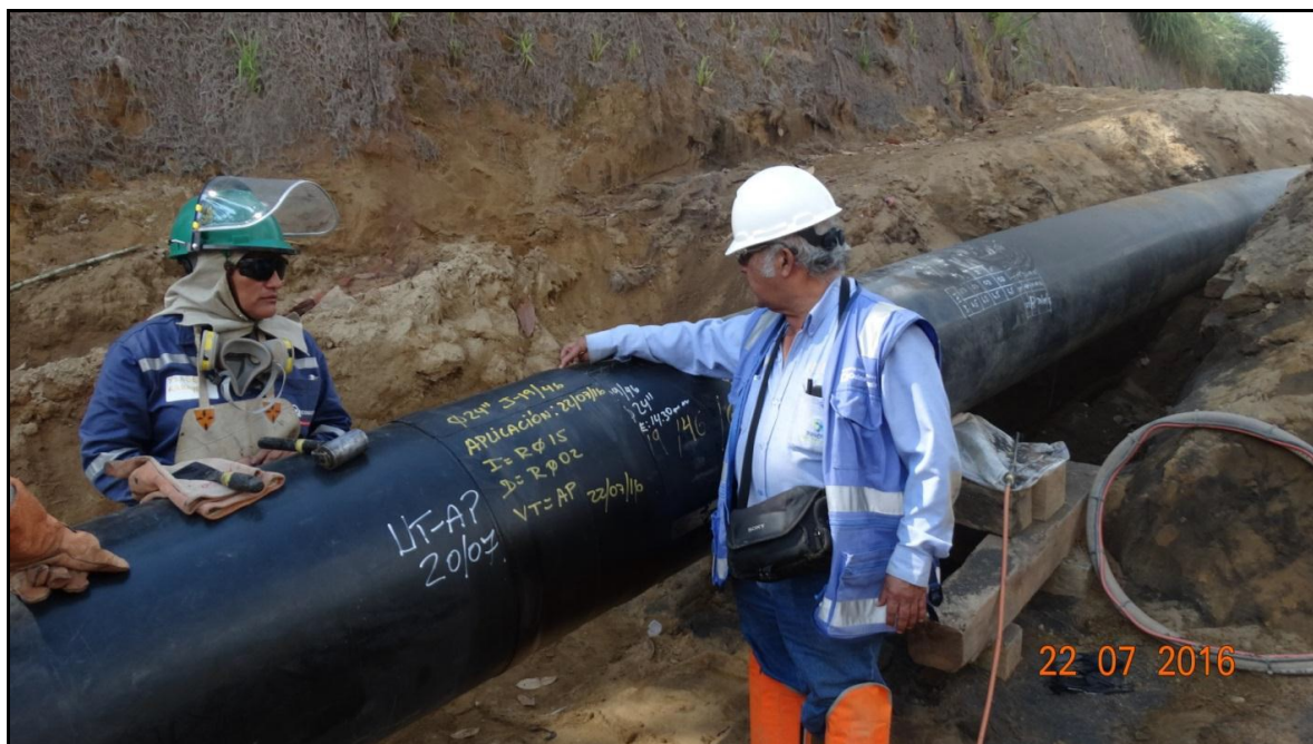
Tramo B – Segmento 1, KP 19+550 Supervisión de manta termocontraible colocada en la junta de soldadura del ducto de 24" Ø.
