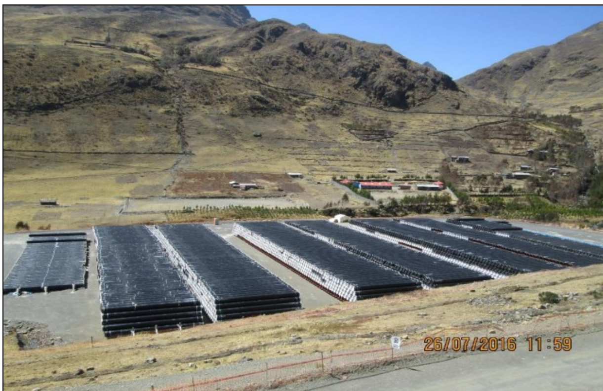
Tramo A1 – Segmento 5, Acopio Acchahuata Verificación de la integridad de tubos en los acopios
