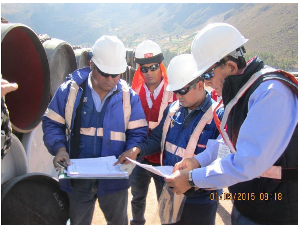
Acopio de Calca, instantes en que supervisor Osinergmin verifica en campo la existencia de los reportes de recepción de tubería.
