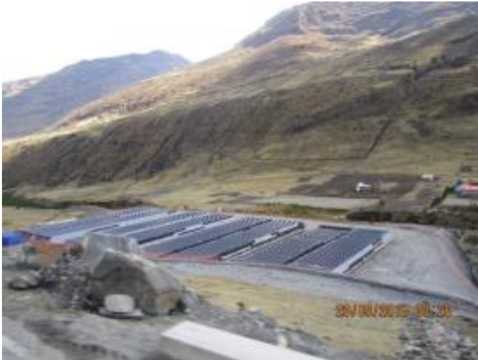
Acopio KP. 276: Vista panorámica en la cual se aprecia el acopio de tubería de 32" de Amparaes.
