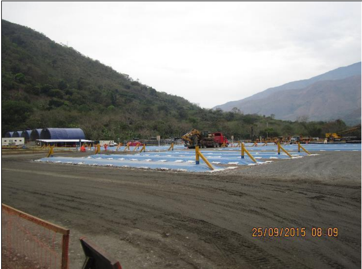
Acopio KP. 28: Vista parcial de acopio en la cual se aprecia una de las áreas destinadas al almacenamiento de tubería de 14”.
