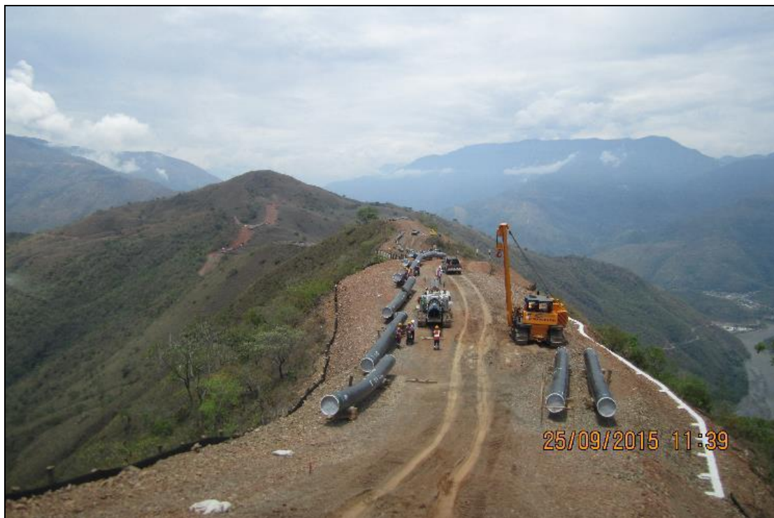
KP. 133. Vista panorámica en la cual se aprecia el desfile de tubería y la máquina dobladora de tubos.
