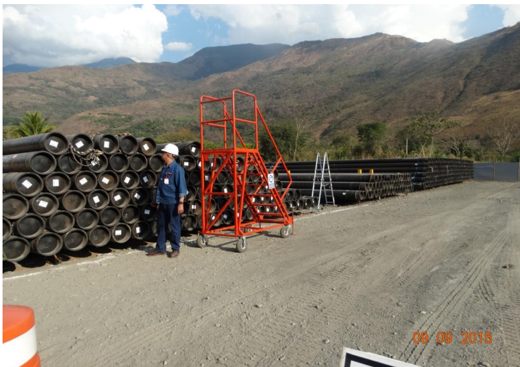
Acopio - Ramal Quillabamba – Vista del almacenamiento de las tuberías de 14” que se utilizará en la construcción del Gasoducto Secundario de Quillabamba. En la vista está el gerente de Calidad de CCDS
