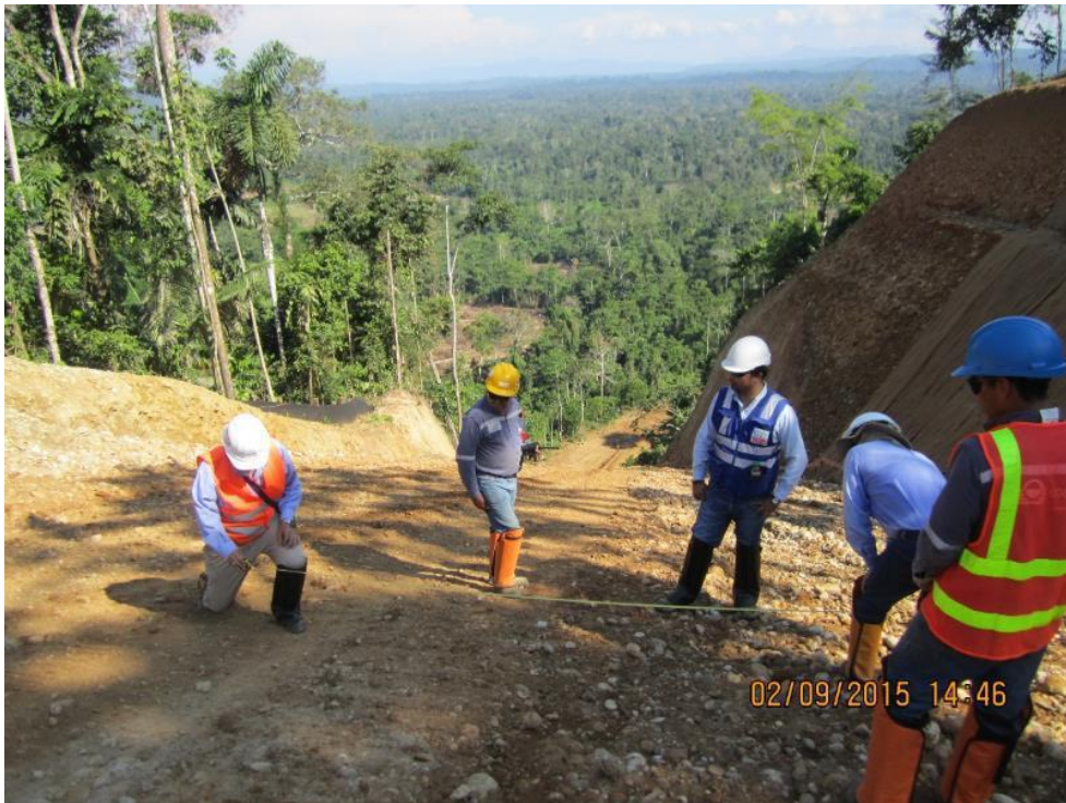
Instantes de la verificación del ancho del DDV en el KP: 08+350, se midió un ancho de 17 metros.
