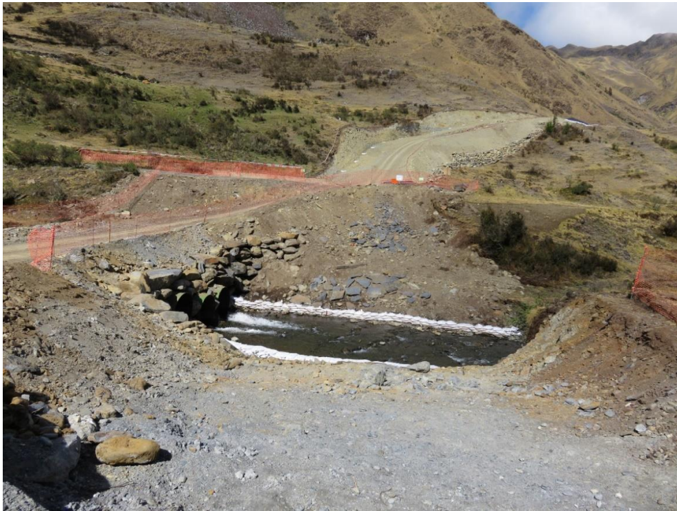
KP 273+100. Obras de geotecnia temporal consistentes en la colocación de alcantarillado en el cauce y barreras de saco suelo en las márgenes, en el cruce del río Amparaes con el DDV..
