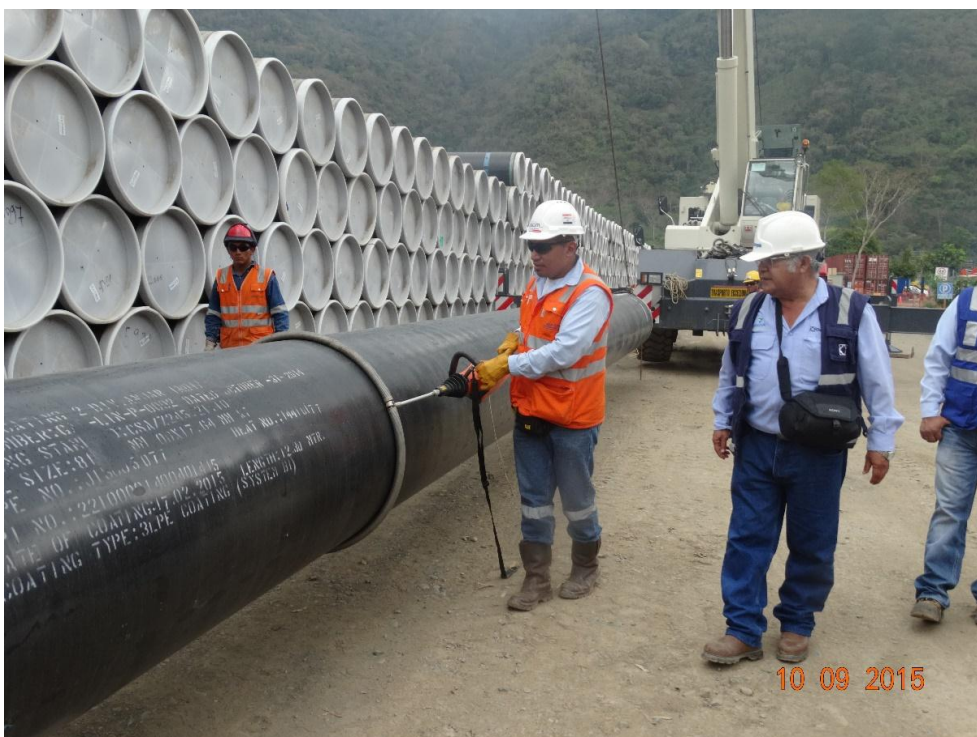
KP 85– Palma Real – Acopio - Tubo 32" N° J15005077 – Vista de supervisor de Osinergmin supervisando la verificando de revestimiento con la herramienta holiday. Antes se verificó certificado de calibración del instrumento
