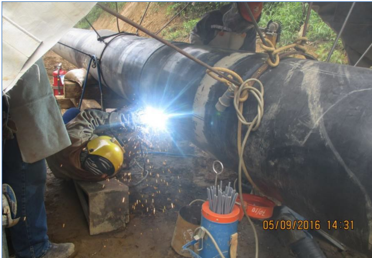
Tramo B – Segmento 01, KP 019+096. Actividad de Soldadura.
