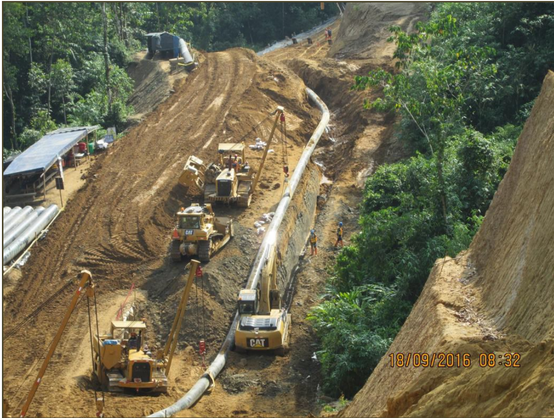
Tramo B-Segmento 1 –KP 006+355. Actividades para el bajado de la tubería de 24” en la zanja.
