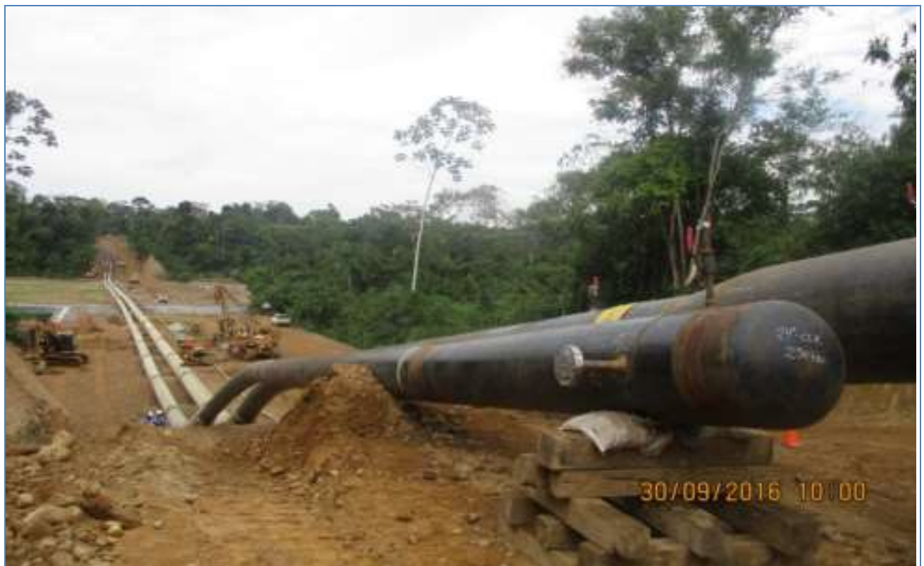
Tramo B – Segmento 01, KP 14+624 Sector en el cual se cruza el río Capanashiari. En un extremo se aprecian los cabezales soldados al ducto.
