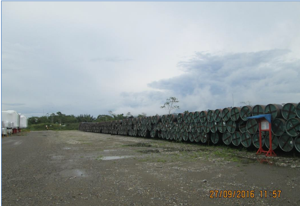
Tramo B – Área de almacenamiento de la Planta Compresora Acopio de los tubos de 24" y 32".
