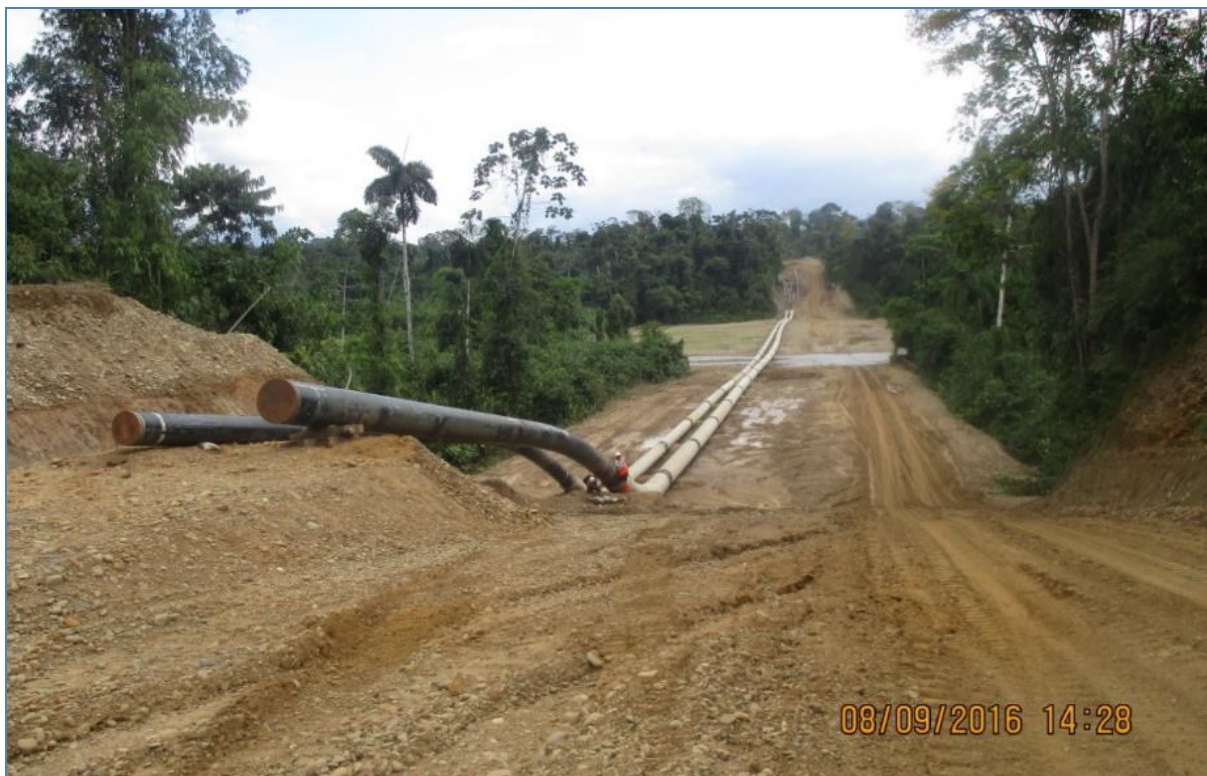
Tramo B – Segmento 01, KP 0014+300
