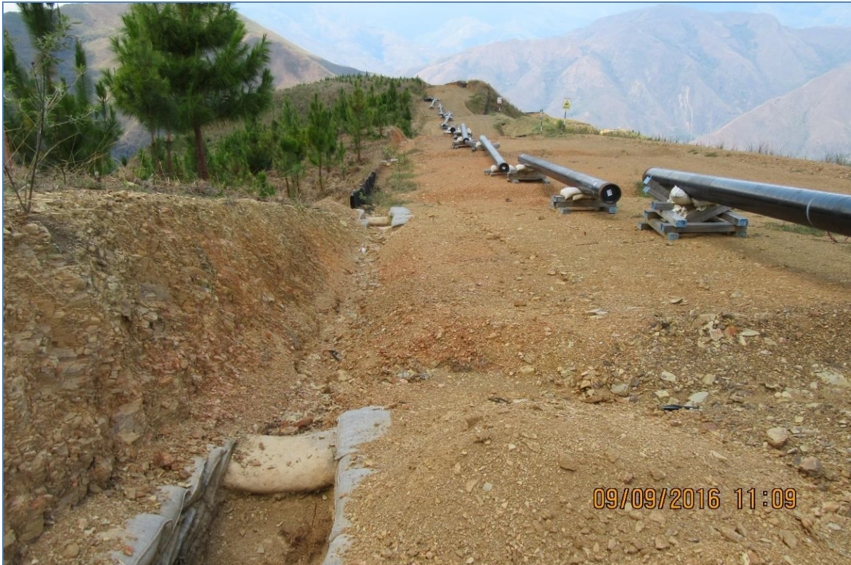
Tramo 1 – Gasoducto a Quillabamba, KP 03+000 Vista de los tubos desfilados
