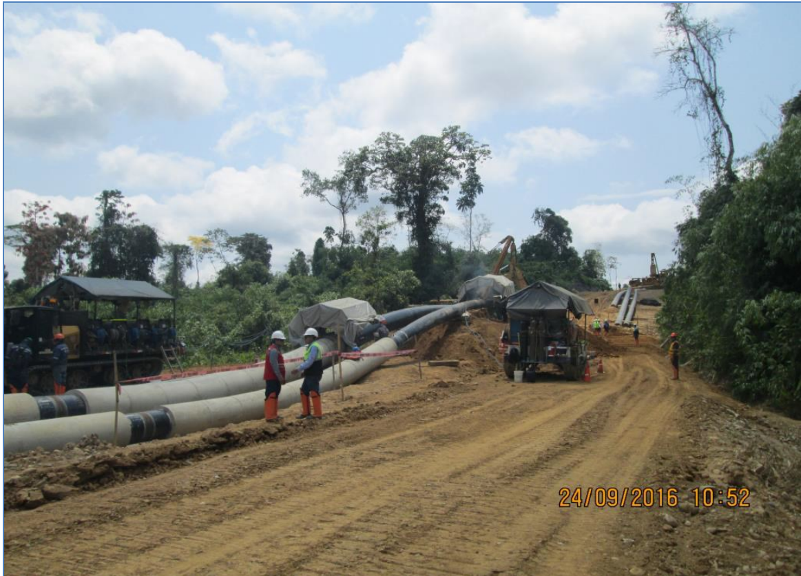
Tramo B – Segmento 01, KP 17+084 Vista panorámica del frente de soldadura
