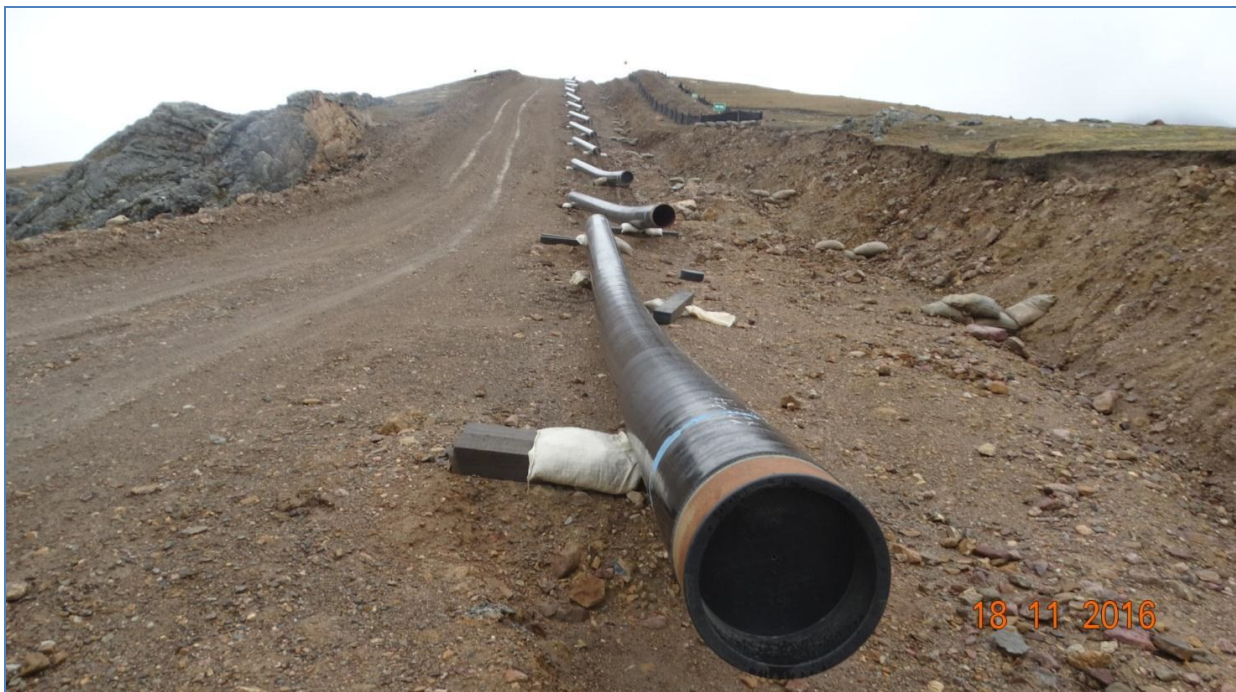
Tramo A1 – Gasoducto Secundario a Anta, KP 9+800 Tubos de 14"Ø. desfilados.
