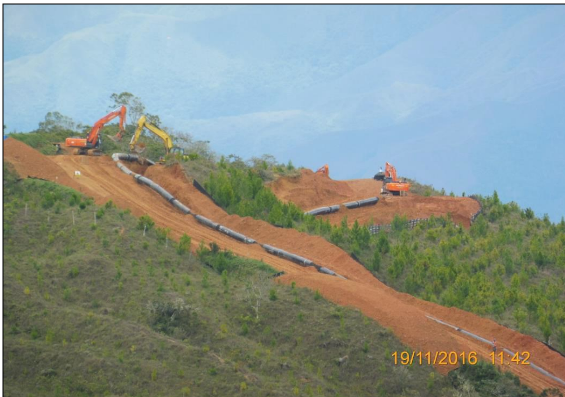
Tramo A1 – Segmento 3, K 143+300 DdV atravesando la línea de cumbres.
