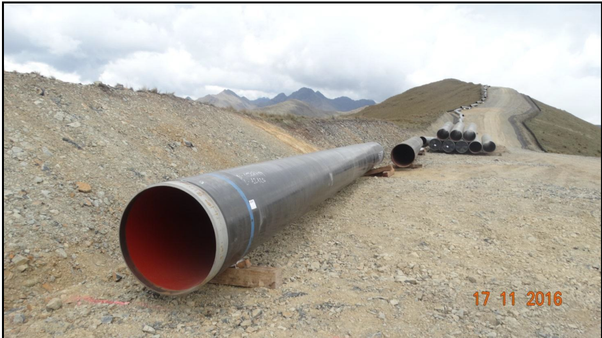
Tramo A1 – Segmento 05, KP 264+400. Tubos de 32"Ø. Desfilados.
