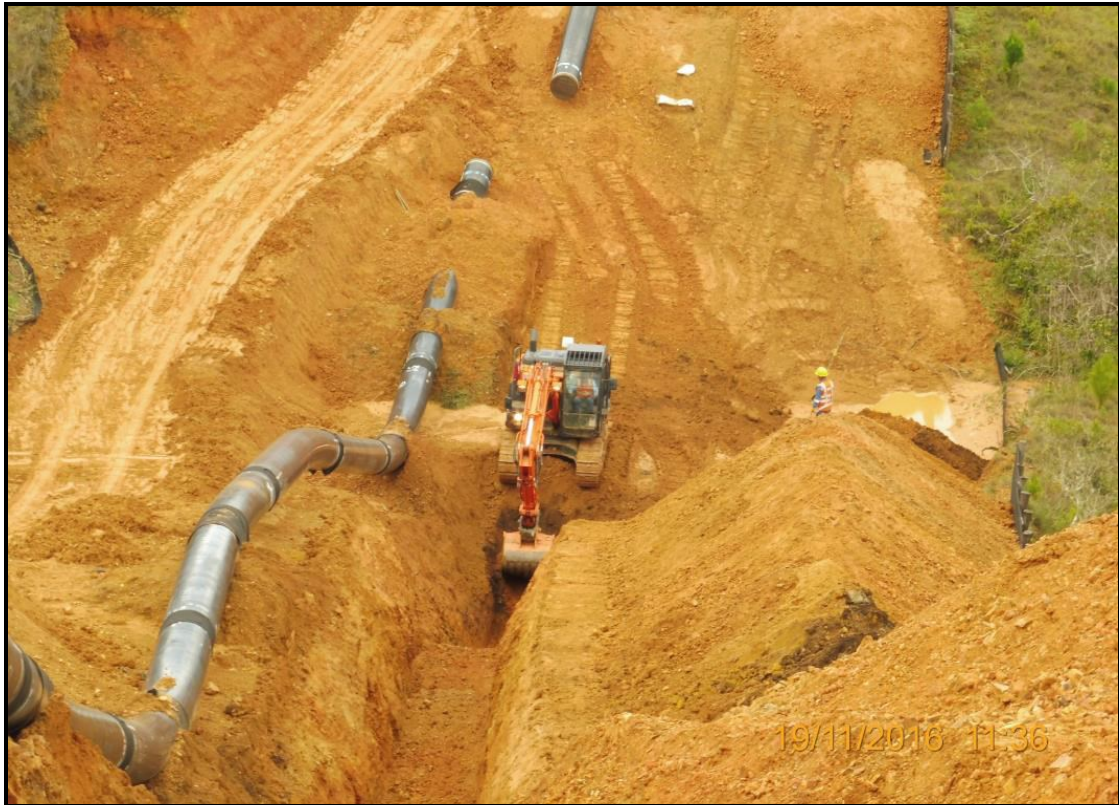
Tramo A1 – Segmento 3, KP 143+800 Excavación de zanja
