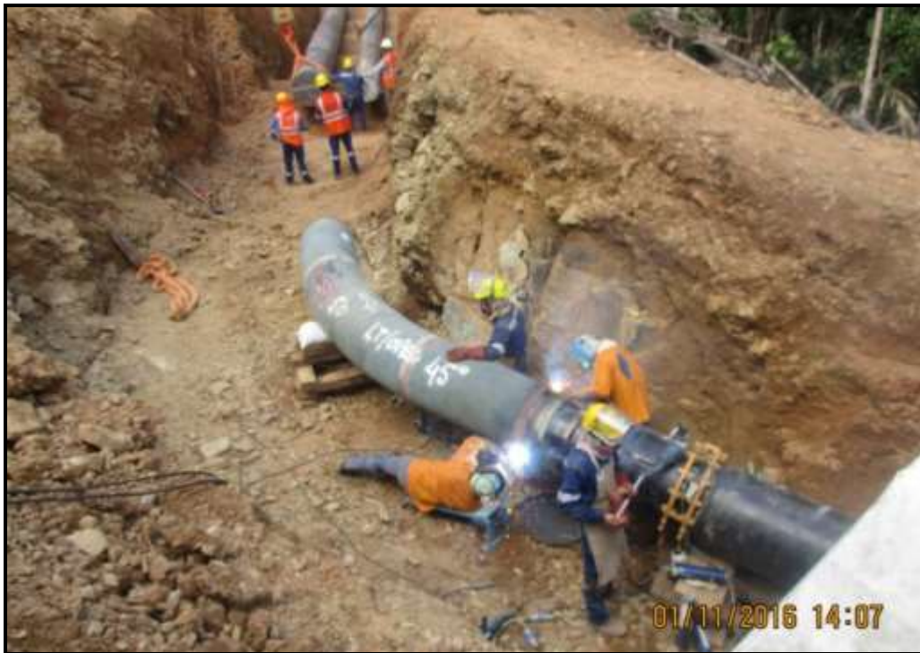
Tramo B – Segmento 02, KP 75+600 Vista panorámica de la actividad de soldadura.
