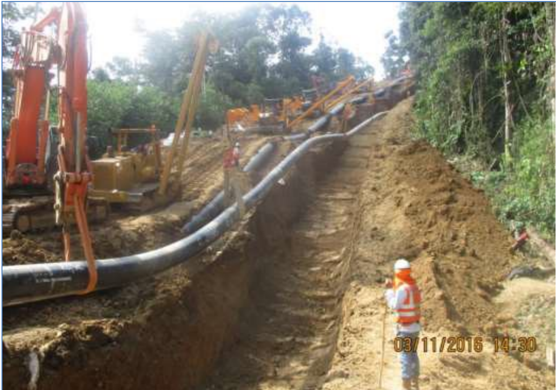
Tramo B – Segmento 02, KP 75+300 Actividad de bajado del ducto de 24"Ø.
