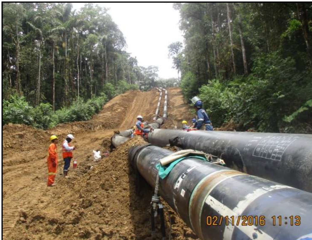
Tramo B – Segmento 02, KP 74+576 Actividades de verificación en el ducto de 32"Ø
