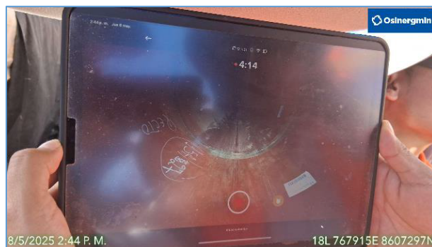
Área 3: Supervisión de los trabajos de extracción de agua en el tramo del kp 154+000 al 154+380: Imagen del interior de la tubería, después del secado con telas absorbentes. No se aprecia agua en el interior.
