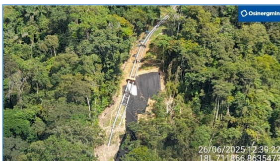
Área 2: Tramo del KP 65+800 al KP 65+900. Vista del asentamiento del DDV. Se aprecia trabajos de mantenimiento de la plataforma y talud del DDV.
