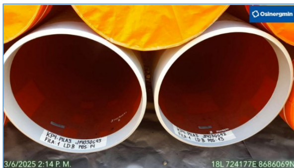
Área 1: Vista de tubería ubicada en el Acopio KP 4+500. Se verifica los trabajos de inspección y preservación en los extremos de los tubos
