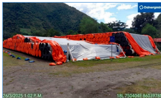
Área 3: Vista del Acopio Palma Real. Verificación de las actividades de preservación de la tubería, la cual cuenta con cobertura de lona, y los extremos tapados.
