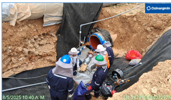
Área 3: Supervisión de los trabajos de extracción de agua en el tramo del KP 154+000 al 154+380: Ingreso de un patinete con bomba sumergible, a fin de extraer el agua a través de la tubería de PVC instalada para tal fin.
