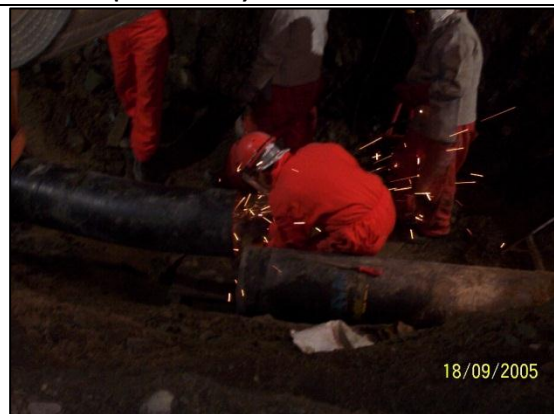
Imagen 06: Preparación de la junta del tramo reemplazado. (18.09.2005)
