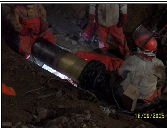
Imagen 07: Soldadura del tramo reemplazado. (18.09.2005)
