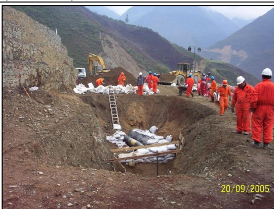
Imagen 09: Trabajos de reconformación de la zona donde se produjo la falla. (20.09.2005)
