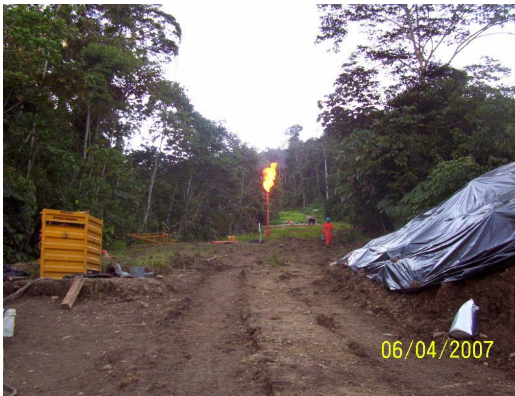
Quema de los gases venteados del tramo a reparar
