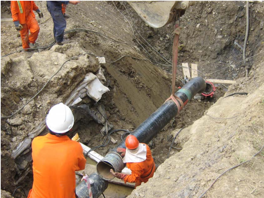
Presentación para alineación del tramo a reemplazar
