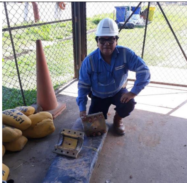
Figura 05: Supervisión de Osinergmin verificando las grampas temporales que se habrían afectado durante la reparación.
