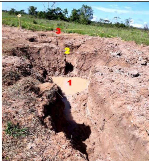
Figura 03: KP 81+550, vista del área afectada donde se aprecia la zanja abierta para las actividades de reparación. Adicionalmente se dispusieron 3 hoyos protegidos con geomembrana, para drenaje temporal del LGN.
