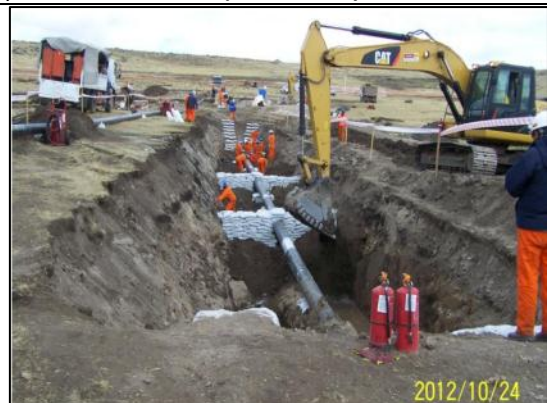
Imagen 15: TGP realiza actividades de protección del tramo reemplazado. (24.10.2012)
