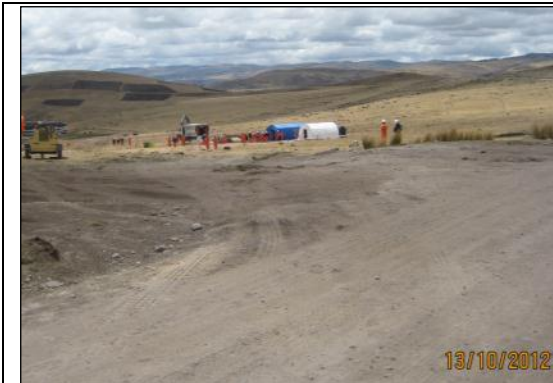
Imagen 05: Campamento instalado y maquinaria trasladada a la zona del incidente. (13.10.2012)
