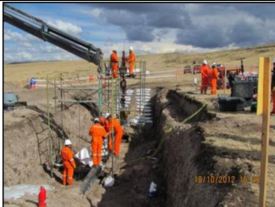
Imagen 14: Vista de la zanja abierta aguas arriba del punto de anomalía. Personal de TGP realiza labores de Hop Tapping. (18.10.2012)
