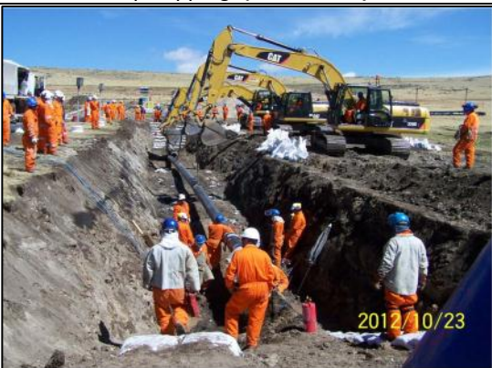
Imagen 14: TGP realiza reemplazo de la tubería afectada. (23.10.2012)
