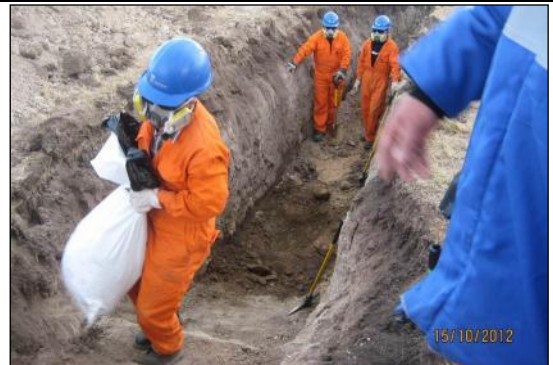
Imagen 09: Personal de TGP retirando material oleofílico impregnado de LGN de la zanja ubicada a 20 metros (15.10.2012)
