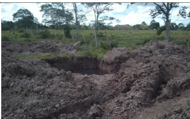
Figura 08: Excavación de pozos para retener el líquido de gas natural (LGN)
