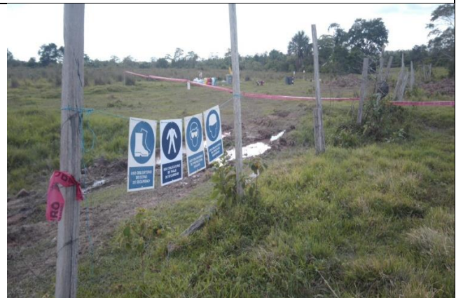
Figura 07: Vista de los trabajos preliminares de seguridad implementados en la zona de trabajo.
