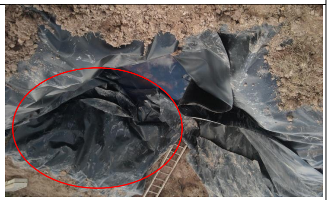
Figura 09: Dentro del pozo colocaron geomembrana (plástico) y sobre ella se encuentra el LGN retenido.
