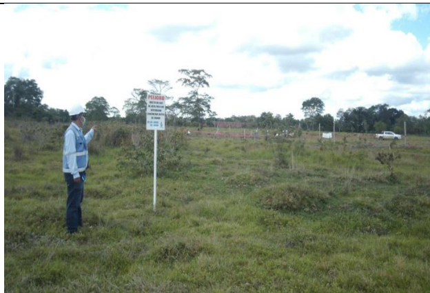
Figura 06: Vista del personal de Osinerghmin de la oficina regional de Pucallpa, en la zona de falla del ducto de LGN.
