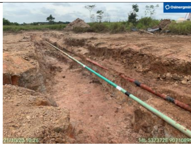
Figura 08: Vista de ducto después de las acciones de reparación realizadas por AEP.
