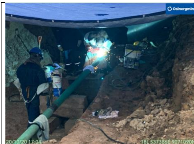
Figura 07: Vista de la verificación in situ de los trabajos de soldadura realizados en la zona de falla del ducto de 4" LGN.
