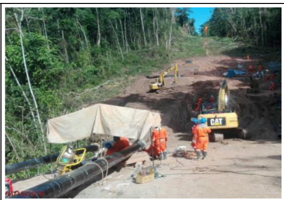
Imagen 27: KP 8+900, Vista de los trabajos de construcción del bypass de 14" para transporte de LGN.
