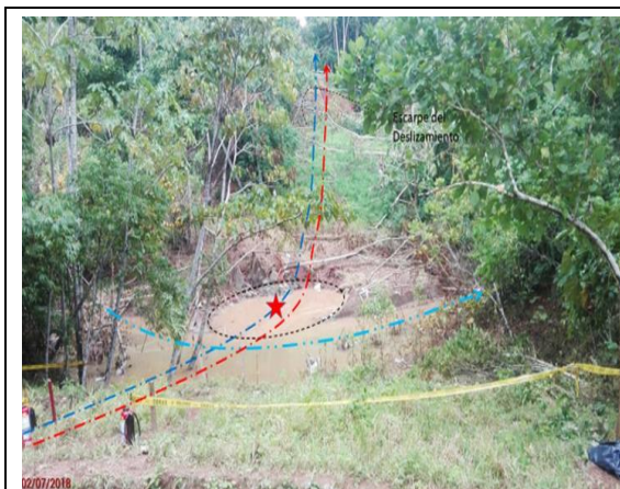
Imagen 03: KP 8+900, Vista de zona de la rotura de la tubería de LGN, con burbujeo de vapores de LGN. (07.02.2018)
