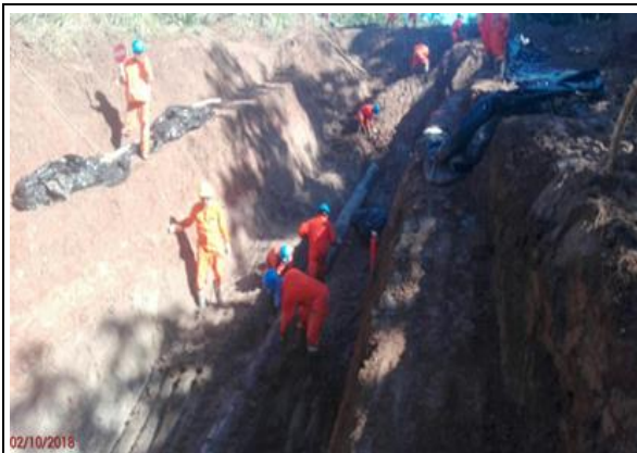
Imagen 22: Vista de las actividades de excavación de tubería de 14" en dirección a Malvinas. (10.02.2018)
