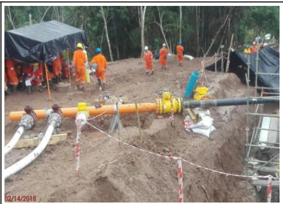
Imagen 23: KP 9+170, Vista de trabajos de instalación del spool, manifold, válvulas y tuberías flexibles. (14.02.2018)
