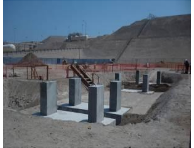
Foto 2. Cimentación para puentes de Estación de Carga
