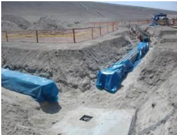
Foto 3. Instalación de bancoductos a Estación de Carga
