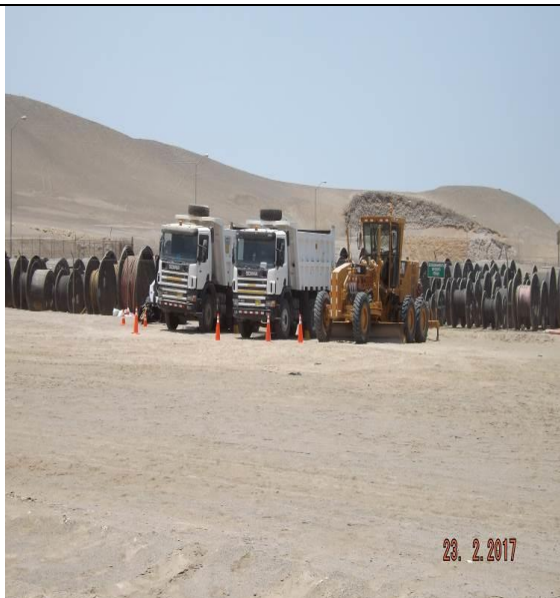
Foto 3. Vista de camiones volquetes y motoniveladora.
