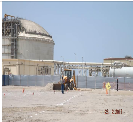
Foto 5. Vista de excavación para cimentación de soportería de tubería de GNL (pipe rack)
