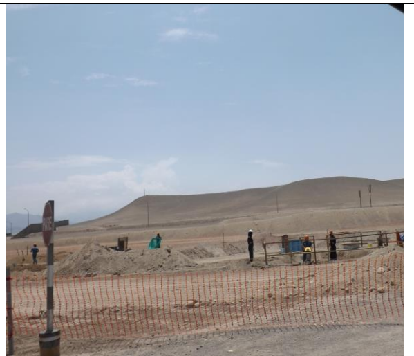
Foto 6. Vista de grupo trabajando en relleno de pozos de tierra
