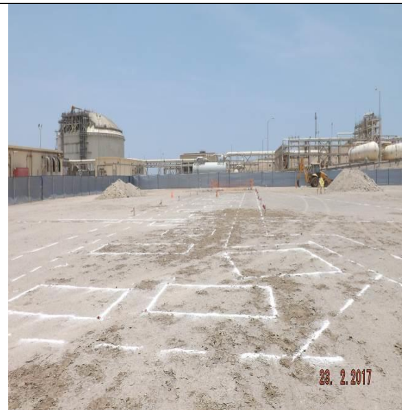
Foto 4. Vista Panorámica del trazado donde se instalarán las bases de los soportes de tubería de GNL (pipe rack)
