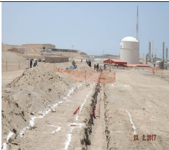
Foto 1. Vista de los trabajos de instalación de mallas de puesta a tierra.
