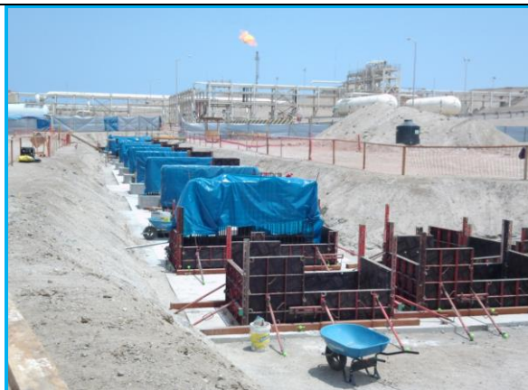
Foto 1. Construcción de pedestales de soportería para las tuberías
