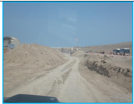
Foto 2. Vista panorámica del acceso de camiones a cargadero de GNL
