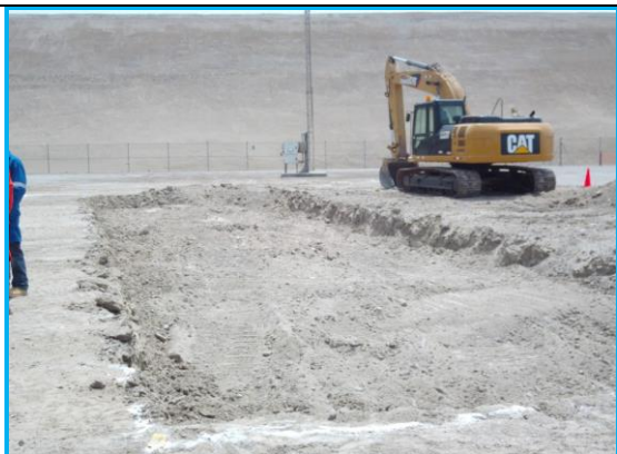
Foto 4. Excavación en zona de carguío de GNL a camiones
