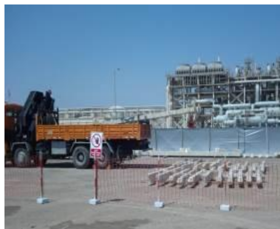
Foto 4. Vista de prefabricados para soportería de tuberías
