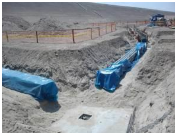
Foto 3. Instalación de bancoductos a Estación de Carga
