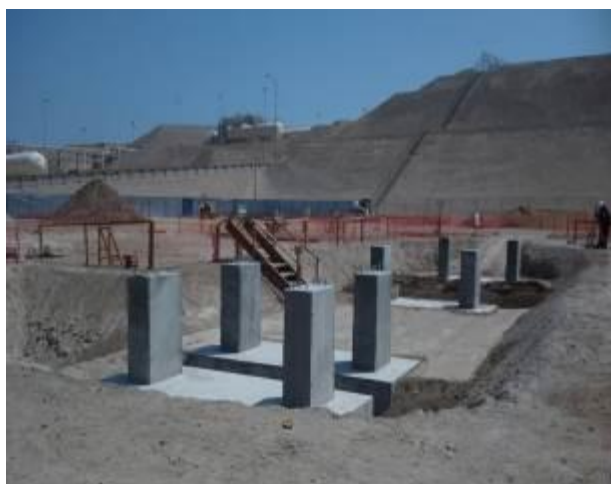
Foto 2. Cimentación para puentes de Estación de Carga
