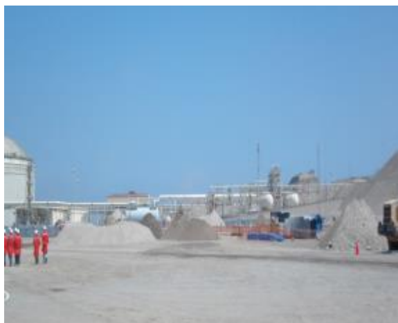
Foto 1. Vista panorámica de trabajo en la zona de carguío
