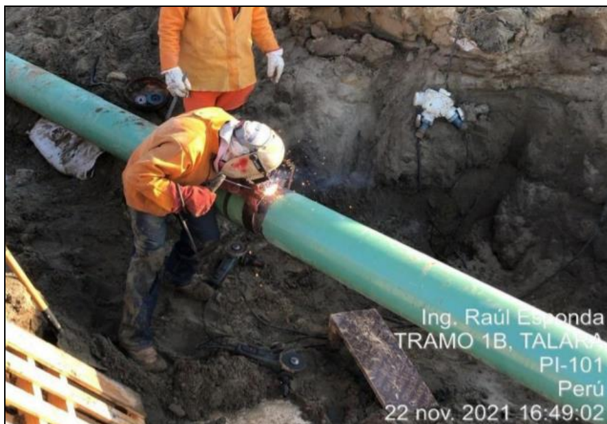
Foto: Se aprecia el proceso de soldadura de tubería de \varnothing 10'' , corresponde a la construcción del tramo 1B del gasoducto.
