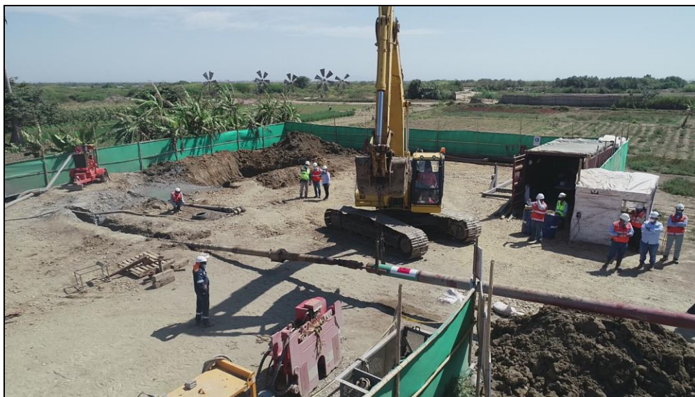
Foto: Proceso de halado de tubería de Ø10" como parte de los trabajos del cruce especial del rio Chira - Tramo 03 del gasoducto
