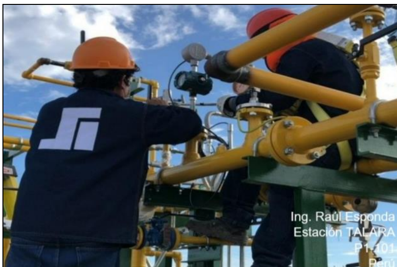
Foto: Se observa los trabajos de mantenimiento de instrumentos en el Skid de regulación y medición de gas.
