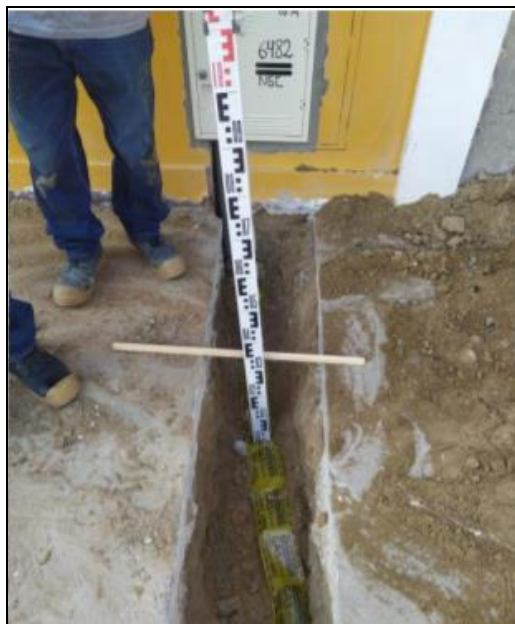
Foto: Se verifica la instalación de la cinta de señalización sobre la tubería de conexión.
