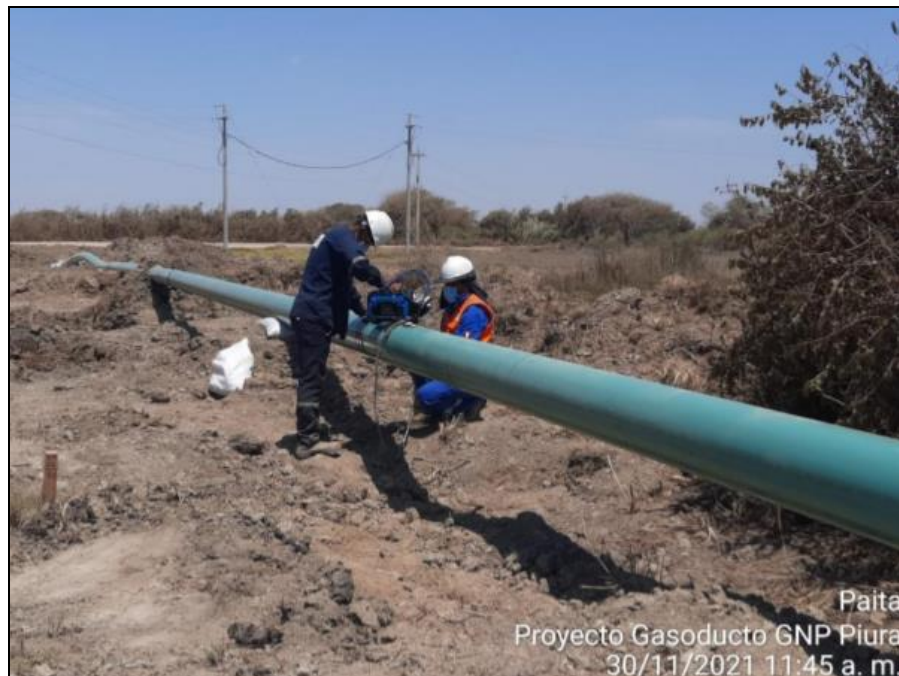
Foto: Se aprecia la prueba de ultrasonido a la tubería de \varnothing 10'' , corresponde al tramo 4 del gasoducto.
