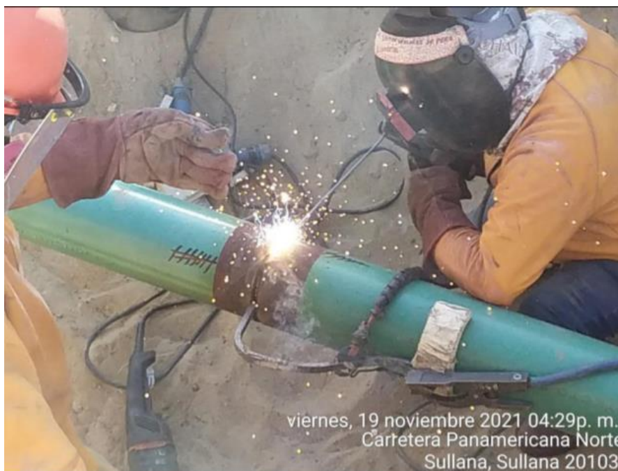
Foto: Se aprecia el proceso de soldadura de tubería de \varnothing 6'' , corresponde a la construcción del tramo 6 del gasoducto.
