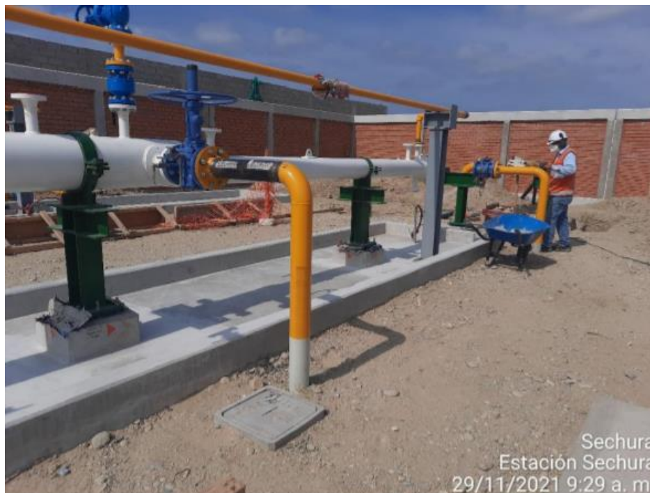
Foto: Se observa los trabajos de instalación de prefabricado de tuberías en las trampas lanzadora y receptora de “pig”.
