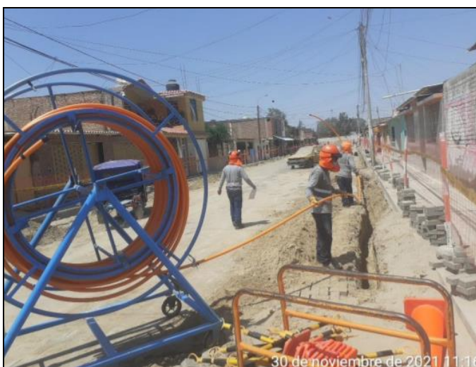
Foto: Instalación de tubería de polietileno en el distrito Veintiséis de Octubre.
