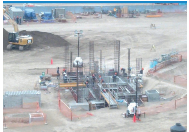
Vista de la construcción del cuarto de control.
