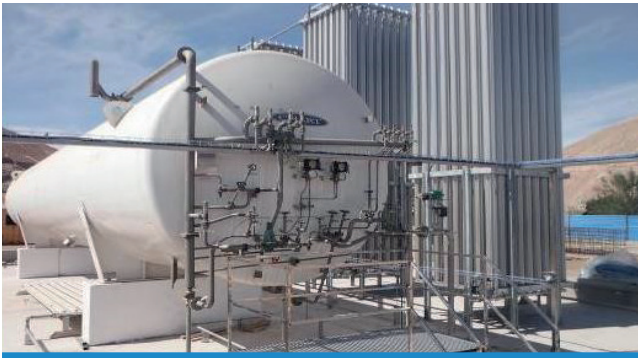
Vista de la Estación de Moquegua.
