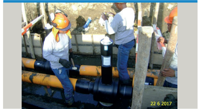
Redes de Chimbote: Instalación de poliválvula en tuberías de PE Ø200 mm por electrofusión en Av. Brasil.
