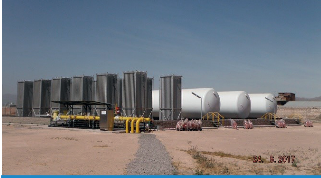
Vista de la Estación de Arequipa Norte.
