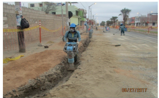
Redes Tacna: Verificación de la compactación en zanja en el Distrito de Tacna.
