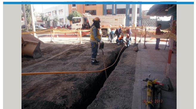
Redes Arequipa: Instalación de tubería de Ø25 mm en el Distrito de Jose Luis Bustamante y Rivero.
