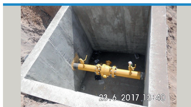
Cámara de válvula, ERP Chilca 02, distrito de Chilca, provincia de Cañete.
