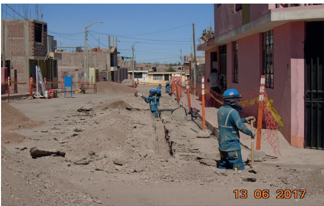
Redes Moquegua: Verificación de la excavación de zanjas en forma manual en el CP de San Antonio-Moquegua.
