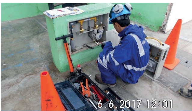
Revisión quinquenal de acometida e instalación interna domiciliaria, distrito y provincia de Pisco.
