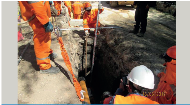
Redes Cajamarca: Verificando la distancia de seguridad a interferencia.
