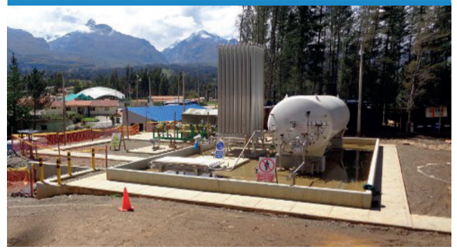
Vista de Estación de Distrito de Huaraz.
