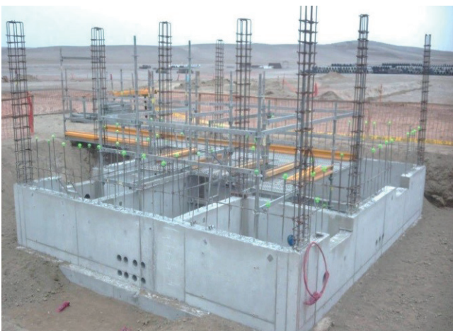
Cimentación de la oficina de recepción de camiones cisternas.
