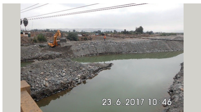
Cruce de río Cañete, Extensión de Red a Protissa, distrito de San Vicente de Cañete, provincia de Cañete.
