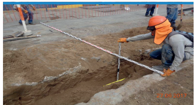
Redes de Trujillo: Registro de verificación de los límites de propiedad en Av. América Sur cdra.12.
