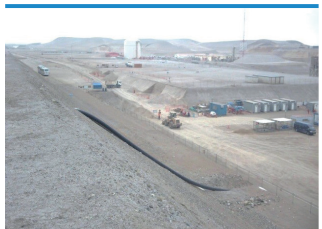
Vista del camino de acceso de camiones cisternas.
