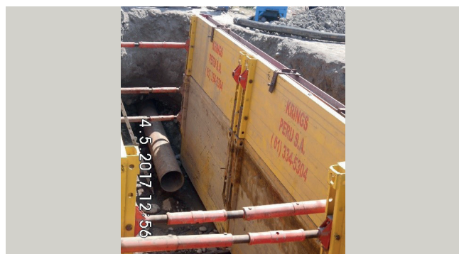
Cruce especial (canal de regadío), Extensión de Red a Protissa, distrito de San Vicente de Cañete, provincia de Cañete.
