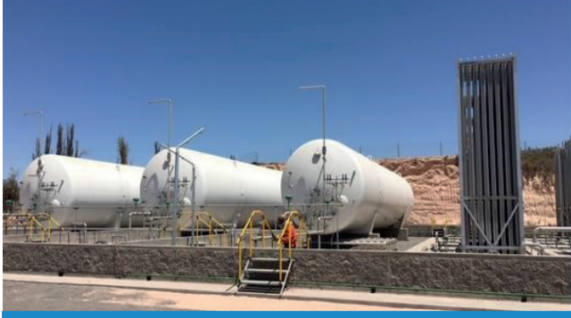
Vista de la Estación de Arequipa Norte.
