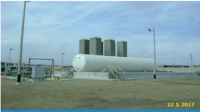
Vista de la Estación de Distrito de Chimbote.
