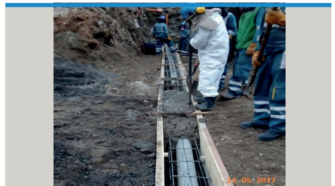
Redes Arequipa, Cruce Especial Torrentera: Instalación de tubería PE de Ø90 mm.
