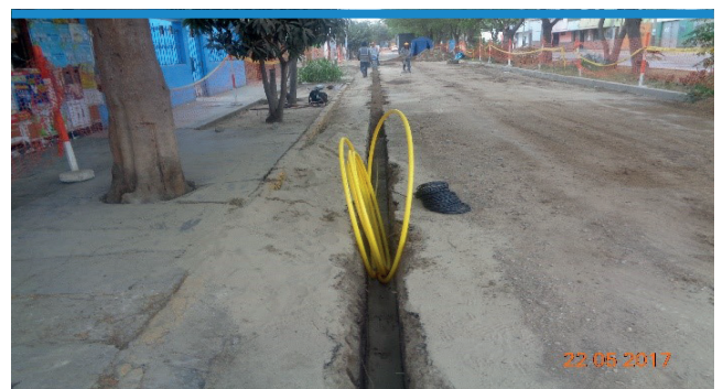
Redes de Trujillo: Instalación de tubería de PE de \varnothing 32mm en Av. Honorio Delgado. Urb. El Bosque.
