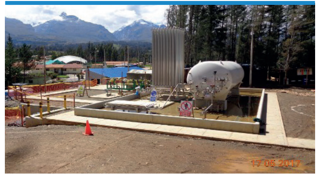
Vista de Estación de Distrito de Huaraz.
