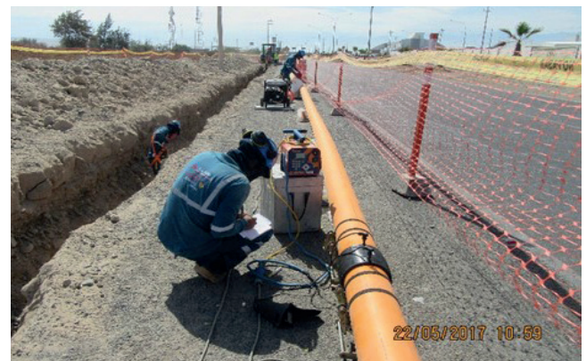
Redes Tacna: Verificación de la profundidad de tubería de Ø200mm.
