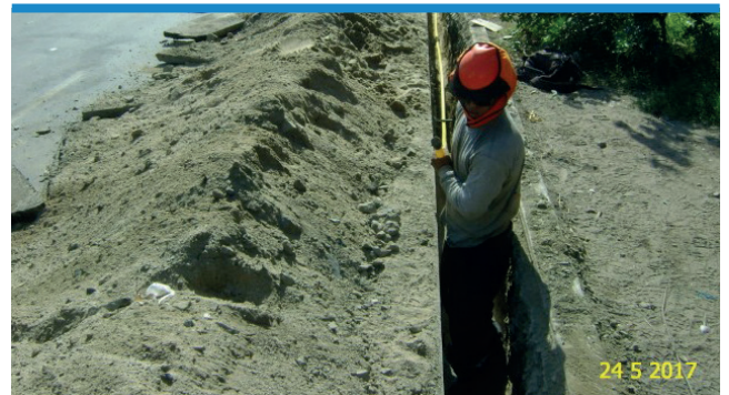
Redes de Chimbote: Instalación de tubería de PE \varnothing 32 mm en la Jr. María Parado de Bellido.
