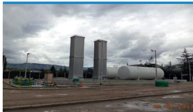
Vista de la Estación de Distrito de Cajamarca.
