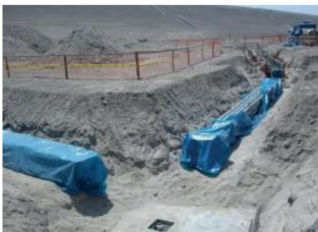
Instalación de bancoductos a Estación de Carga.
