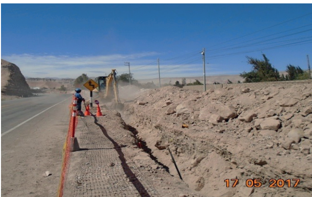
Redes Moquegua: Verificación de la excavación de zanja para tubería de Ø160mm.
