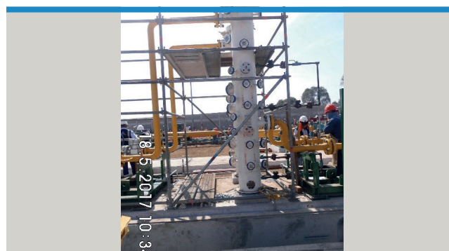
Instalación de filtro separador, City Gate Cañete, distrito de San Vicente de Cañete, provincia de Cañete.
