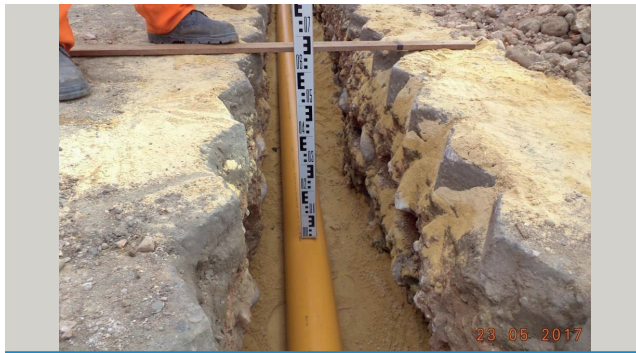
Redes Cajamarca: Calle Pachacútec Cdra. 5: Verifiqué la tapada de tubería, la cual cumple mayor a 0.61m.
