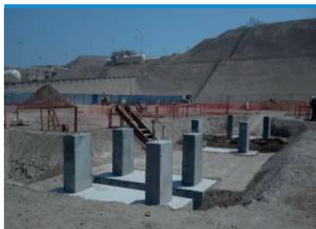
Cimentación para puentes de Estación de Carga.
