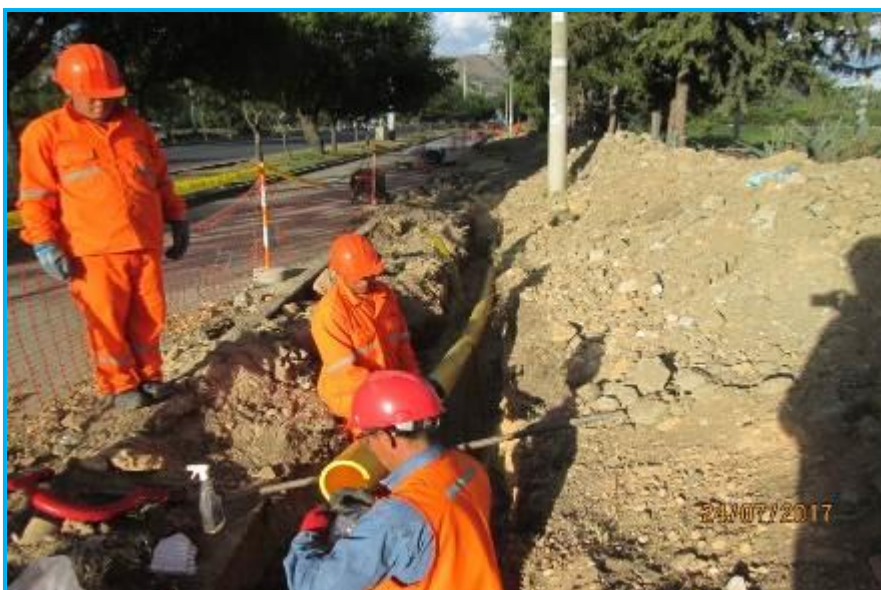
Foto 12.- Redes Cajamarca, vista de la instalación de tubería PE Ø160mm. Ref. Avenida Atahualpa.
