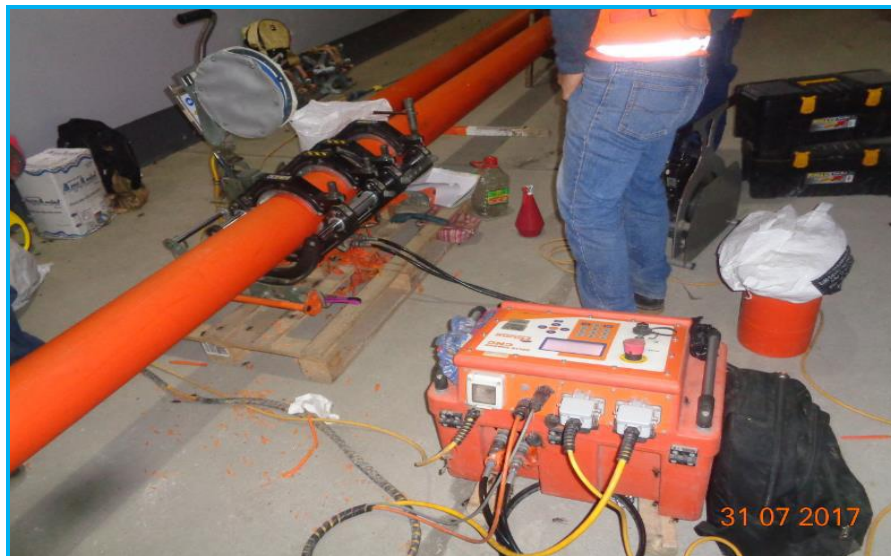
Foto 09.- Redes Trujillo, vista de unión por Termofusión a tope a tubería de PE Ø200mm, Ref. Av. Industrial.
