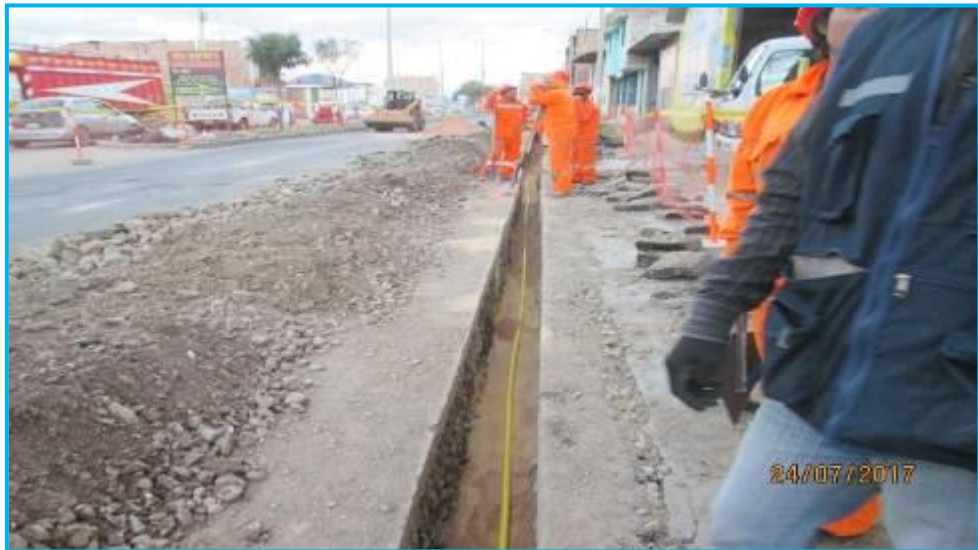
Foto 13.- Redes Cajamarca, vista de la instalación de tubería PE Ø32mm. Ref. Vía de Evitamiento Sur.
