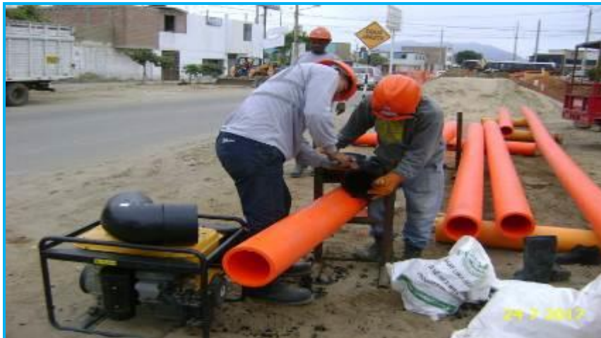
Foto 11.- Redes Chimbote, verificación de las condiciones físicas de tubería de Ø200 mm, para el inicio de las juntas por electrofusión. Ref. Jr. Miraflores con Av. Pardo – Chimbote.
