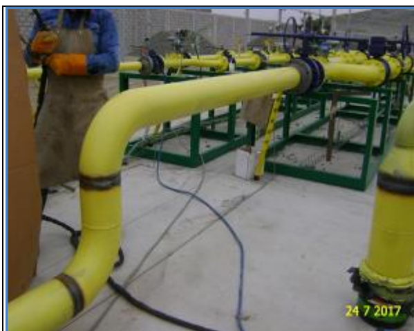
Foto 16.- E.D. Chimbote, vista de los trabajos de soldadura en acero al carbono en la salida de la ERM.
