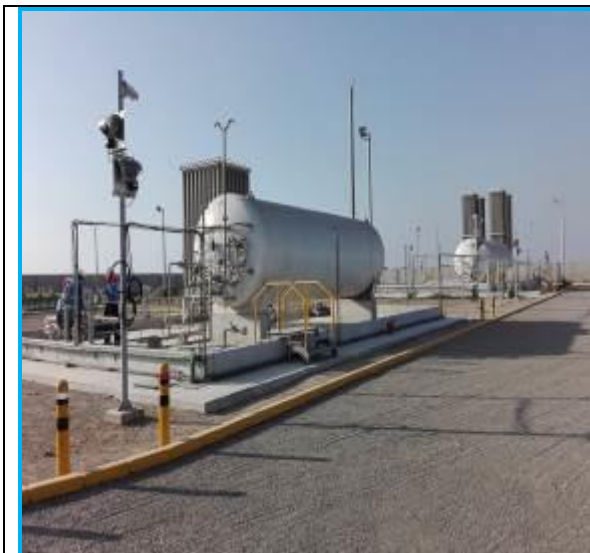
Foto 14.- Lambayeque – Chiclayo, vista de la zona de rodadura de las dos estaciones.
