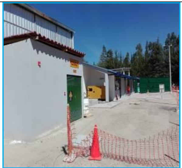
Foto 15.- Cajamarca, vista de zona de Oficinas, cercada por trabajos de instalación de adoquines de concreto para la vía de acceso.
