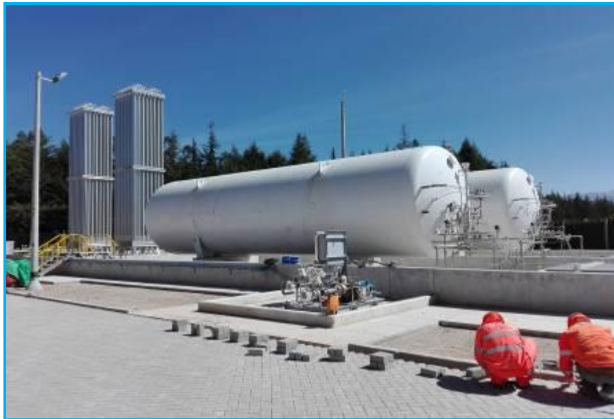
Foto 07.- Vista panorámica de zona de procesos E.D. Cajamarca.
