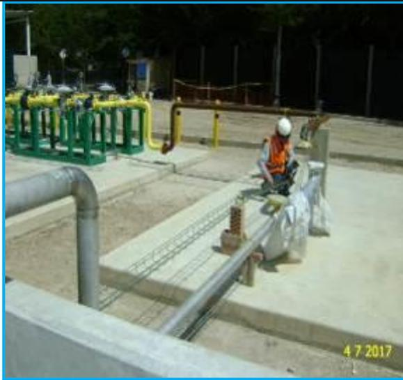
**Foto 14.-Cajamarca,** vista de la instalación de canaletas para cableado eléctrico de instrumentos.
