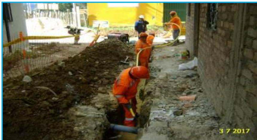
**Foto 12.- Jirón Los Conquistadores Calle S/N:** Instalación de tubería de PE Ø32 mm.
