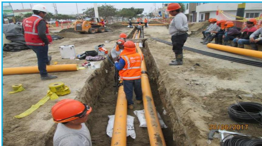
**Foto 10.- Redes Chimbote:** Unión por electrofusión de tubería PE de Ø200 mm. en Av. Perú con Jirón Lima - Chimbote.
