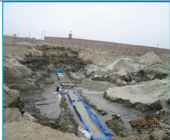
**Foto 17.- Redes Chimbote,** excavación y encofrado para el solado en cruce especial del Río Lacramarca.
