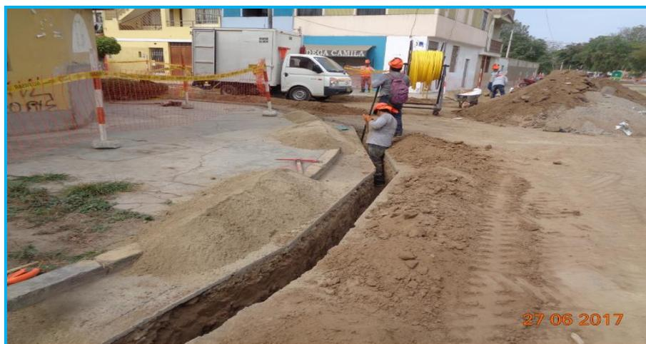
**Foto 08.- Redes Trujillo,** vista de la instalación de tubería de PE Ø32 mm en Calle Nicolás Corpancho y Carlos Baca Flor. Se verificaron distancias de seguridad y profundidad de tapada.
