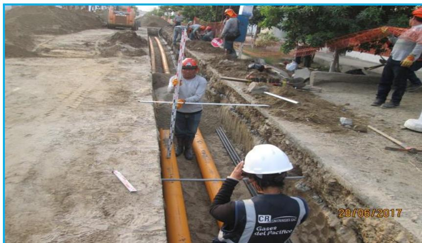
**Foto 11.- Redes Chimbote,** Verificación de las distancias de seguridad.
