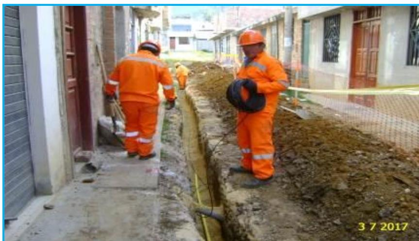
**Foto 13.- Jirón Los Conquistadores:** Instalación de cable conductor eléctrico para detección de tubería de Ø32 mm.
