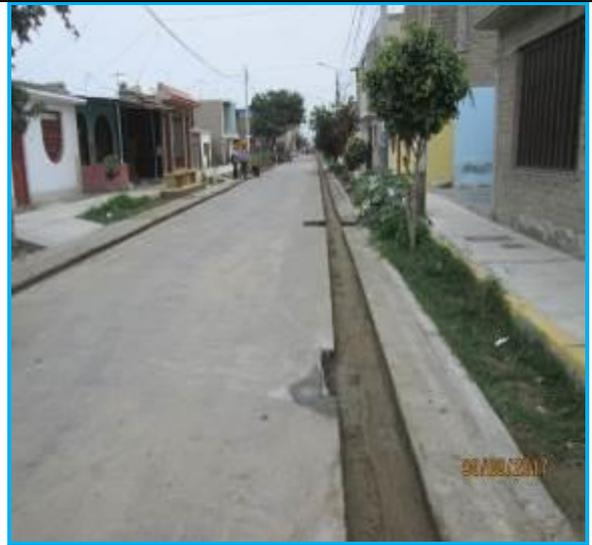
**Foto 15.-Chimbote,** Zanja perfilada y compactada para el relleno con asfalto en Jr. Cuzco.
