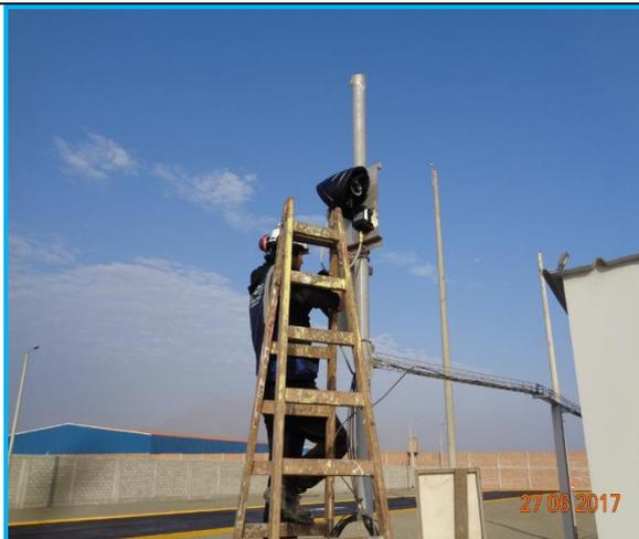
**Foto 16.-Trujillo,** vista de la instalación y cableado del sistema de seguridad Fire & Gas para su conexión al PLC.
