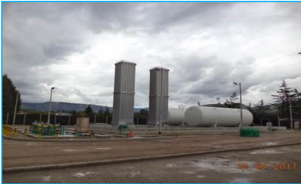
Foto 07.- Vista panorámica de zona de procesos E.D. Cajamarca.
