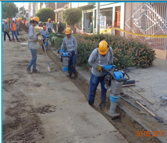
Foto 16.- Redes Trujillo, Etapa de compactación de zanja para tubería de \varnothing 32\text{mm} y \varnothing 63\text{mm} (Calle Bacilio Pacheco cuadra 5). Urb. El Bosque.
