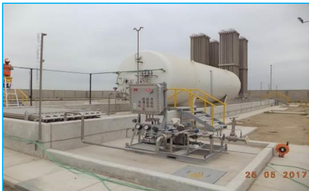
Foto 04.- Vista de la Estación de Distrito de Chiclayo
