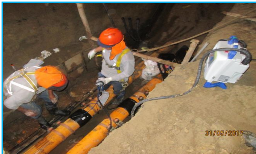
Foto 10.- Redes Chimbote: Unión por electrofusión de tubería PE de Ø200 mm. Jirón Lima - Chimbote.
