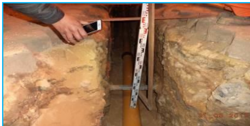
Foto 13.- Calle Pachacútec Cuadra 1, se verificó el cumplimiento de la distancia de seguridad de la tubería de PE con tuberías de otros servicios.
