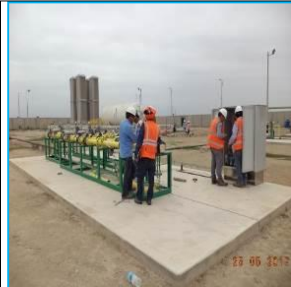
Foto 14.-Chiclayo, vista de la instalación de tuberías de Acero Inoxidable para conectar el Odorizador a la ERM.
