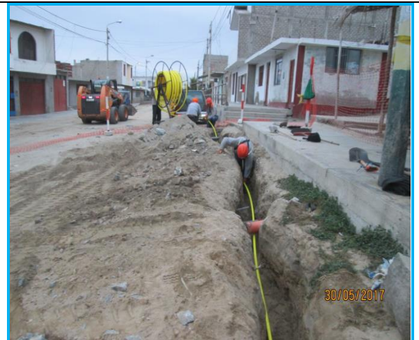
Foto 17.- Redes Chimbote, Instalación de tubería PE de \varnothing 32\text{mm} en Calle Mariano Melgar y Av. Tangay.
