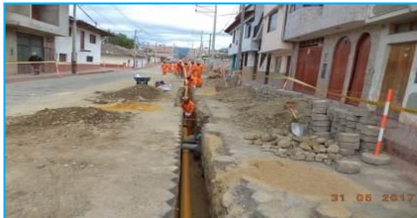
Foto 12.- Calle Pachacútec Cuadra 2: Durante la bajada de tubería 160 mm PE100.
