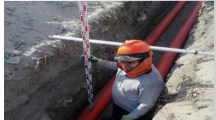
Redes Chimbote: Verificación de la altura de tapada de zanja. Ref. Av. Panamericana Norte.
