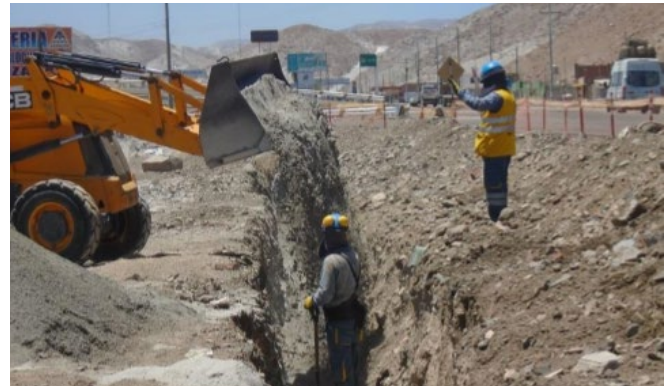
Redes La Joya: Se verifica la instalación de la cama de arena fina en fondo de zanja.
