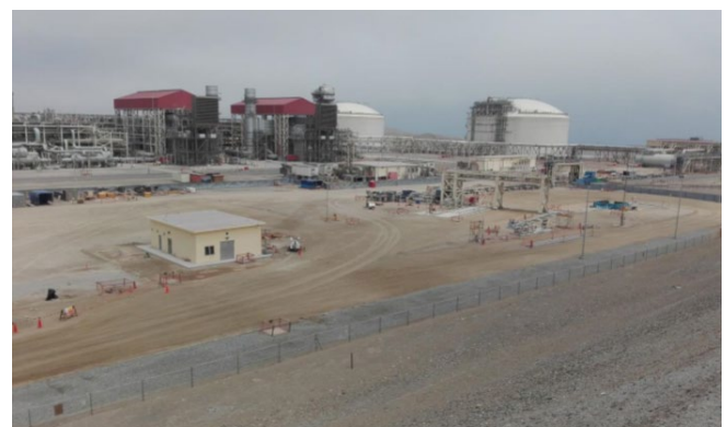
Vista de Bahía de Carga y Edificio de Control de Carga.
