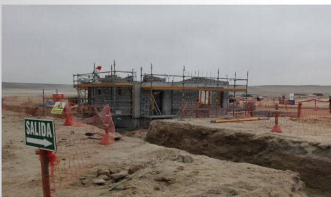
Vista de construcción de edificio de recibo de camiones cisternas y conductores.
