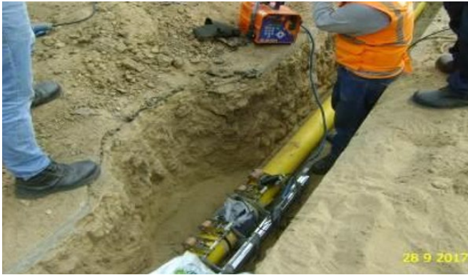
Redes Trujillo: Unión de tuberías de Ø160 mm, mediante de termofusión tipo socket, en Av. Cesar Vallejo.
