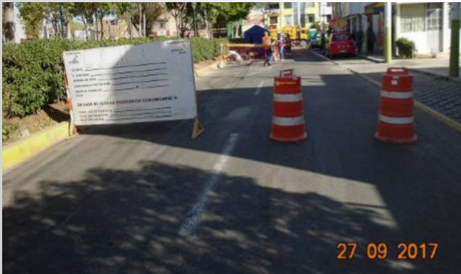
Redes Arequipa: Se verifica la señalización en la zona de trabajo del distrito J.LByR.
