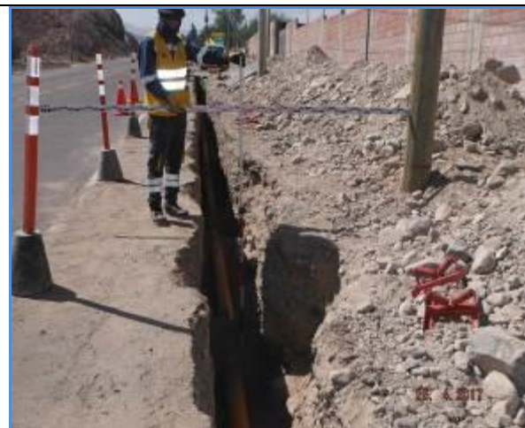
Foto 17.- Instalación de Redes en Moquegua: verificación de la distancia de la tubería de PE hacia uno de los postes.
