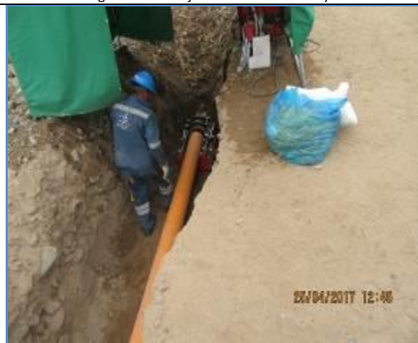
Foto 16- Instalación de Redes en Tacna: verificación de la unión por termofusión a tope de tubería de PE de Ø200 mm.
