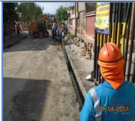
Foto 15.- Redes Arequipa: verificación de instalación de cinta de seguridad en zanja en el Distrito de JLByR.
