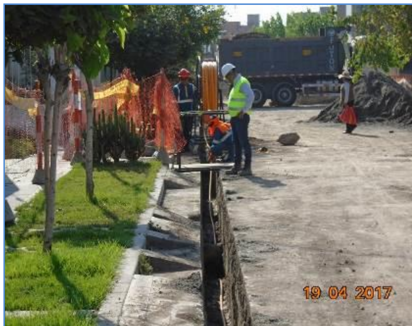
Foto 11.- Redes Arequipa: verificación de instalación de tubería de PE de Ø25 mm en zanja en Distrito de JLByR.
