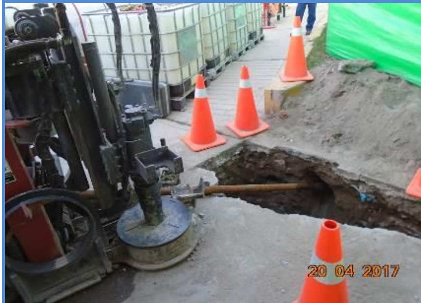
Foto 10.- Redes Arequipa: Se verifica la ejecución de la perforación horizontal dirigida.
