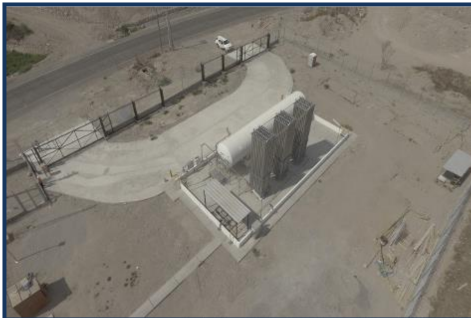
Foto 08.- Vista del estado actual de la Estación de Distrito de Moquegua.
