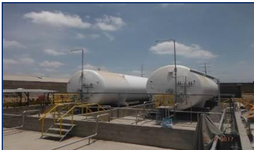
Foto 07: vista del estado actual de estación de distrito de Sabandia
