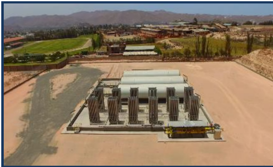
Foto 06: vista del estado actual de estación de distrito de Cerro Colorado
