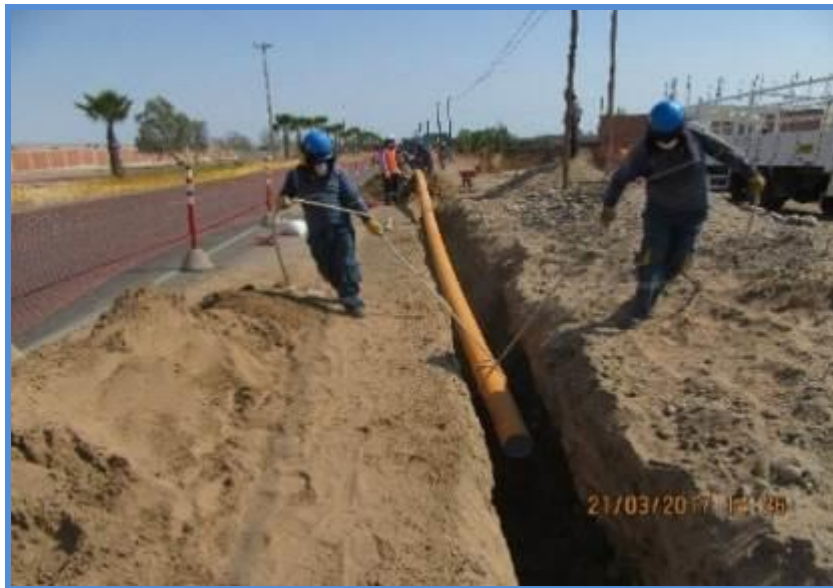
Foto 13.- Instalación de Redes en Tacna: verificación de la instalación de tubería de PE de \varnothing 200 mm.
