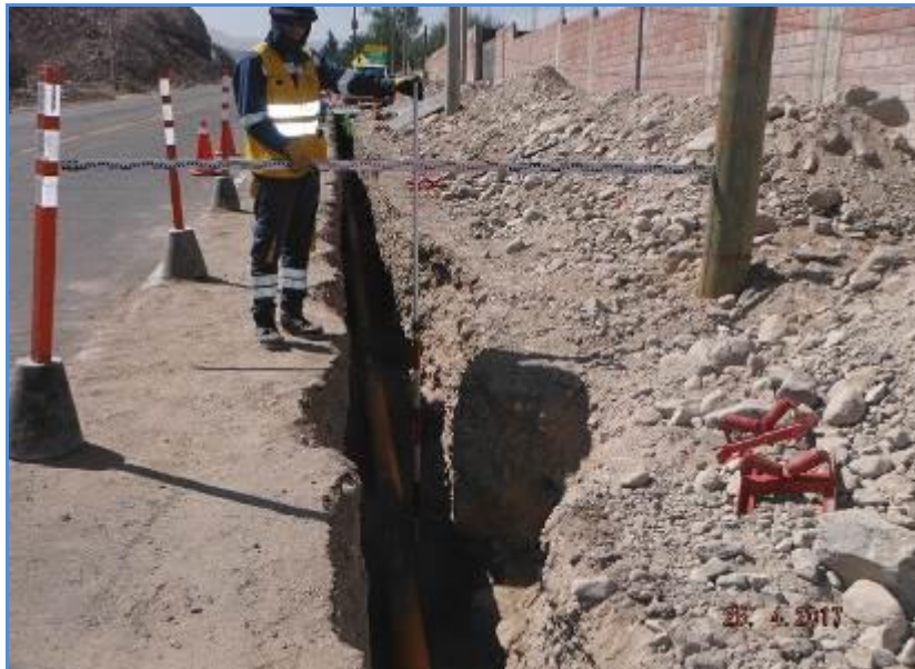
Foto 12.- Instalación de Redes en Moquegua: verificación de la distancia de la tubería de PE hacia uno de los postes.
