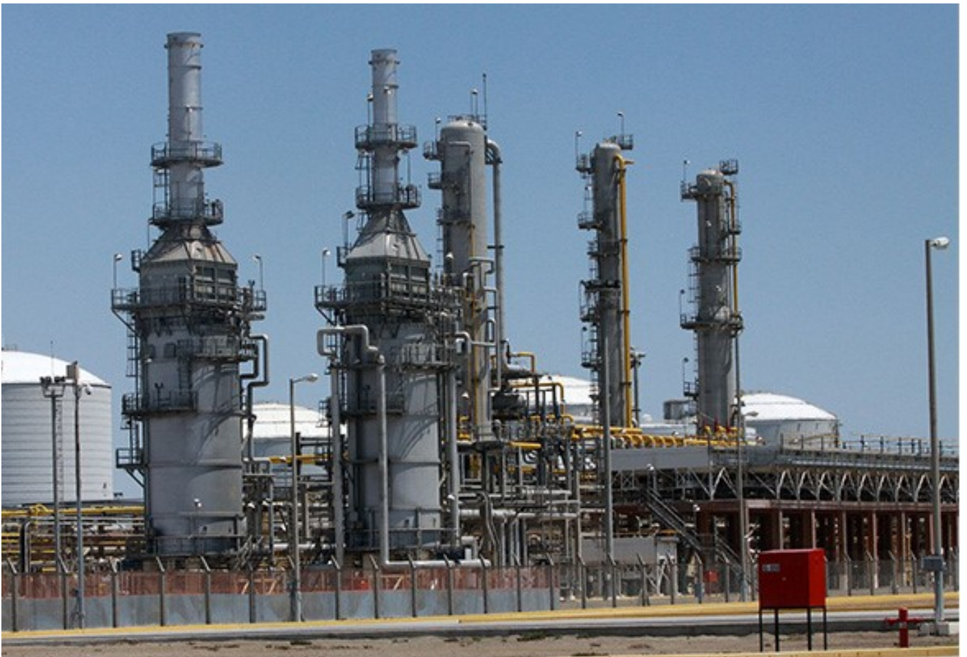
Foto 2. Planta de Procesamiento de Líquidos de Gas Natural, Pisco. División de Supervisión de Gas Natural
