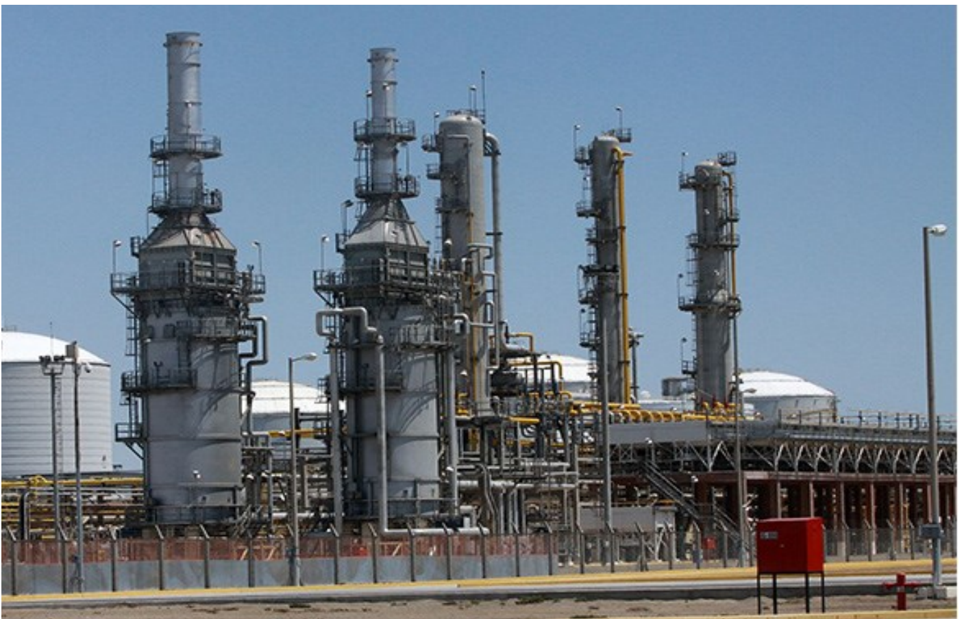
Foto 2. Planta de Procesamiento de Líquidos de Gas Natural, Pisco. División de Supervisión de Gas Natural
