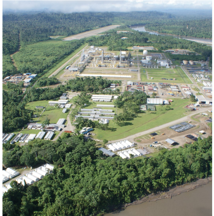
Foto 1. Planta de Procesamiento de Gas Natural, Malvinas. División de Supervisión de Gas Natural
